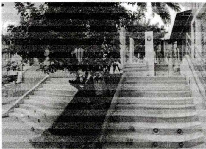
Foto 01: Se puede apreciar que en las jardineras de concreto presentan un deterioro en los sardines, causada por la humedad existente.
