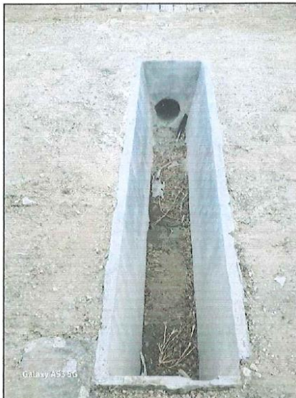
Imagen N° 19-20: Vista de las cajas recolectoras en mal estado, con problemas de sedimentación y poca capacidad de recolección – mal ubicación.
