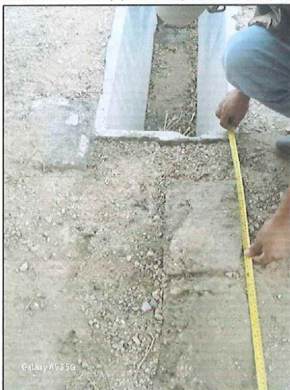
Imagen N° 19-20: Vista de las cajas recolectoras en mal estado, con problemas de sedimentación y poca capacidad de recolección – mal ubicación.
