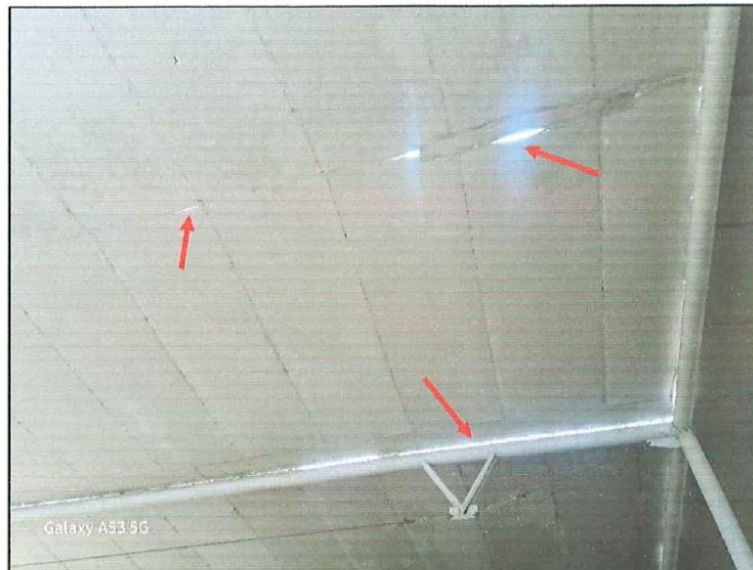
Imagen N° 08: Vista de la Lona en mal estado. - Presenta agujeros.
