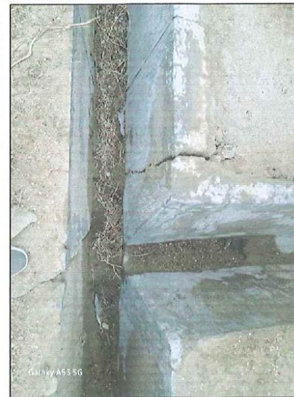
Imagen N° 19-20: Vista de las cajas recolectoras en mal estado, con problemas de sedimentación y poca capacidad de recolección – mal ubicación.
