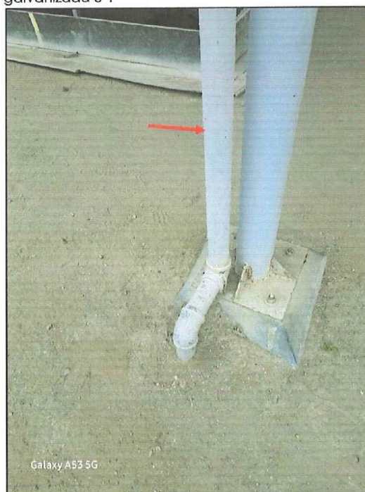
Imagen N° 10: Vista del sistema de drenaje pluvial existente tubería galvanizada de 2". - presenta problemas de pendiente, capacidad de evacuación – cambio po tubería galvanizada 3".
