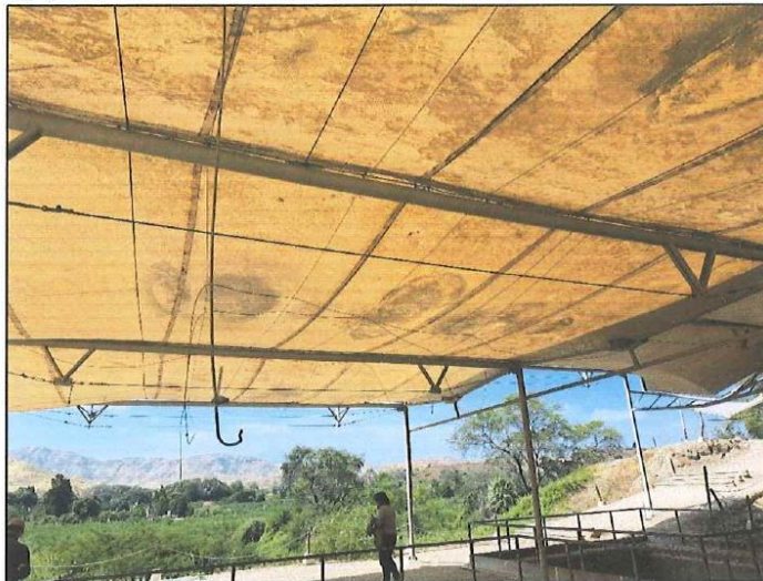
Imagen N° 05: Vista de la Lona en mal estado, TUMBA 8.- Presenta problemas de agujeros, elementos de sujeción (templadores) sueltos.
