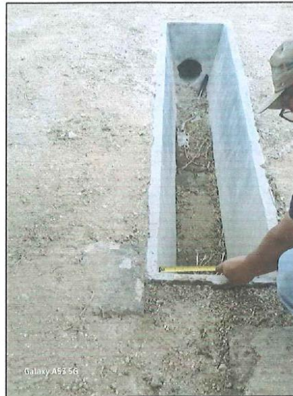
Imagen N° 19-20: Vista de las cajas recolectoras en mal estado, con problemas de sedimentación y poca capacidad de recolección – mal ubicación.
