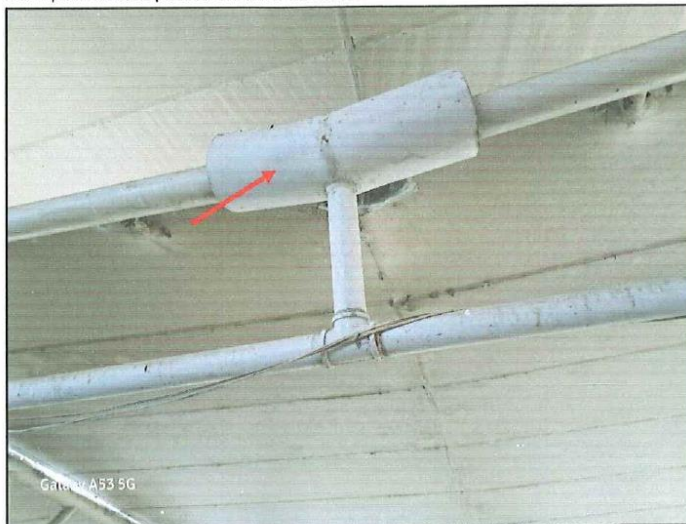
Imagen N° 10: Vista del sistema de drenaje pluvial existente tubería galvanizada de 2". - presenta problemas de pendiente, capacidad de evacuación – cambio po tubería galvanizada 3".
