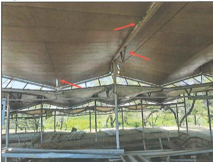
Imagen N° 06: Vista de la Lona en mal estado. - Presenta agujeros.
