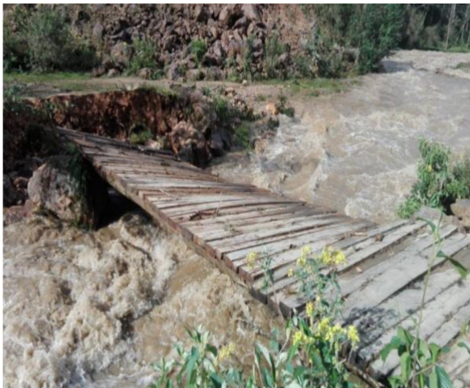
Imagen N°04 Estado Actual de Puente Colapsado.
