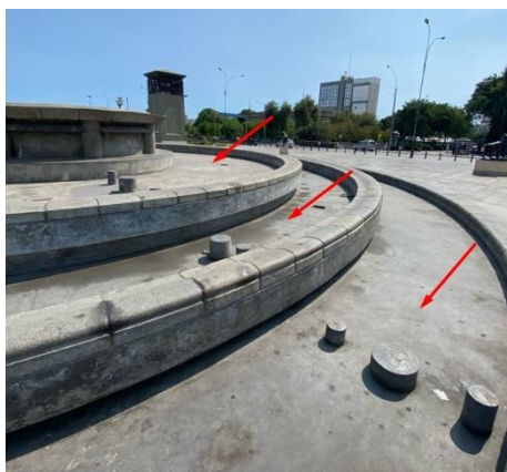
Fig. 13. Fotografía de la pileta donde se observa las zonas a impermeabilizar (paredes y fondo de contenedor)
