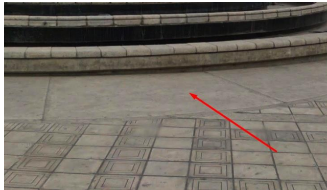
Fig. 20. Fotografía donde se observa el sector de piso de cemento pulido e=8cm A DEMOLER.
