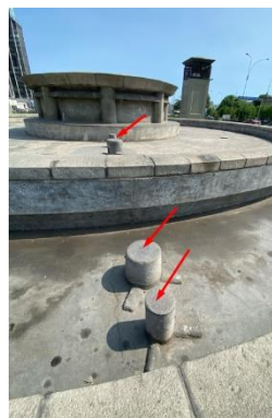
Fig. 22 y 23. Lado izquierdo: Puntos de rojo indica las tuberías rellenas de concreto a demoler. Lado derecho: Fotografía donde se observa las tuberías rellenas de concreto a demoler.
