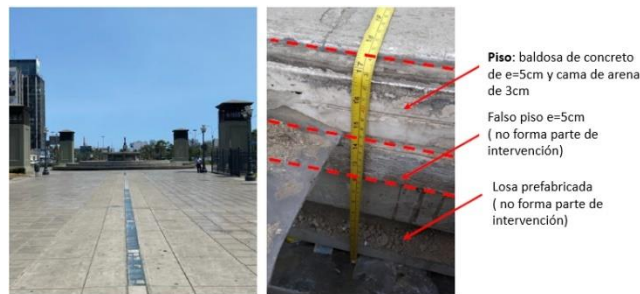
Fig. 15. Corte: Área de rojo indica baldosas de concreto de 40x40cm, e=5cm y cama de arena e=3cm A RETIRAR.
