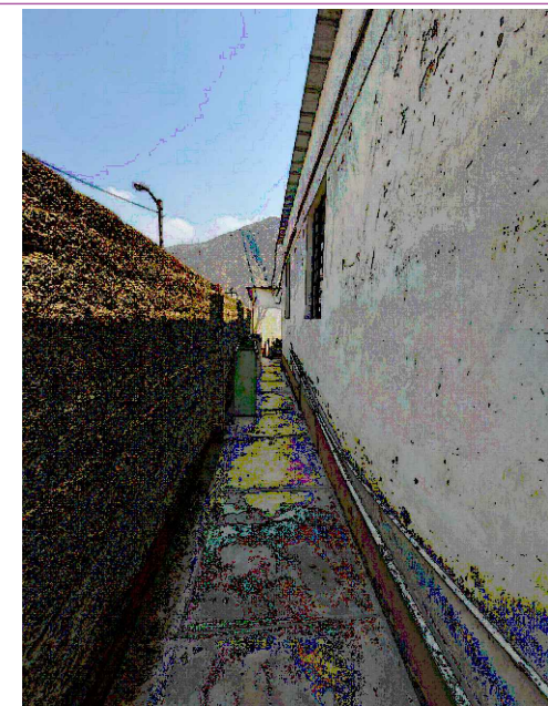
CERCO PERIMETRICO COLINDANTE CON BAJA ALTURA Y EN MAL ESTADO DE CONSERVACION.
