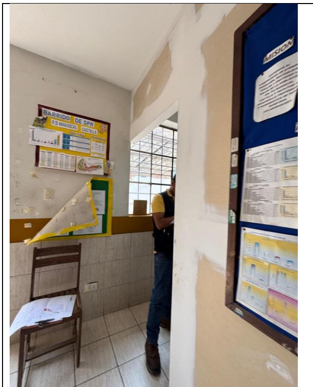
Foto 9. Se observa muros de tabiquería de drywall sin culminar.
