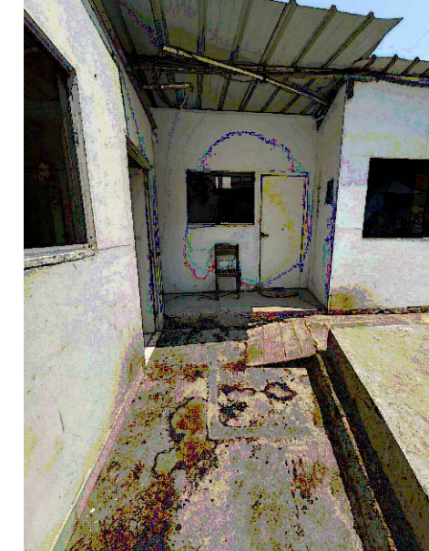
PLATAFORMA -0.30 M: ACUMULACION DE AGUA DE LLUVIA POR ESTAR EN NIVEL BAJO.
