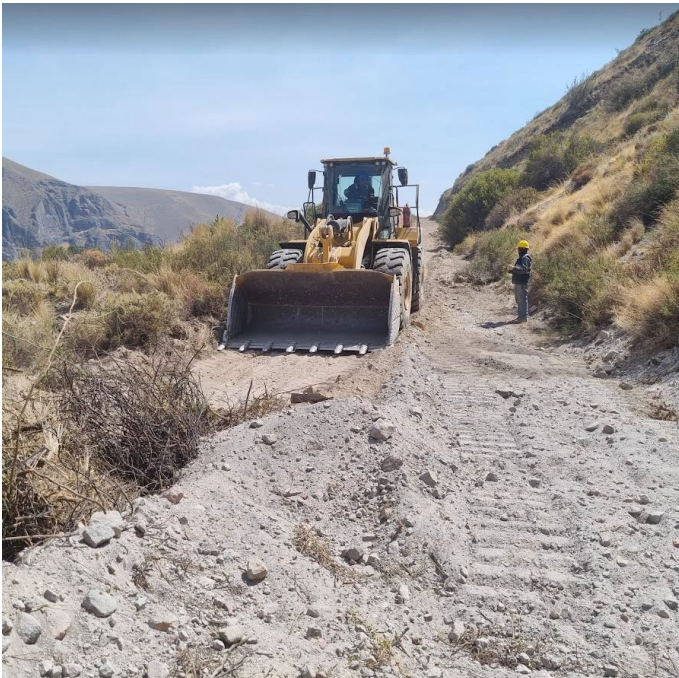
Labores de corte de terreno y eliminación de maleza para conformación de vía con cargador frontal y tractor.
