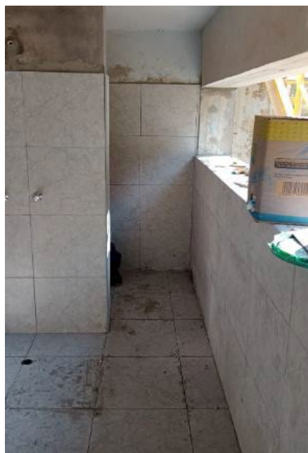
Labores de rehabilitación de cubículos para duchas e inodores en servicios higiénicos de personal mecánico.
