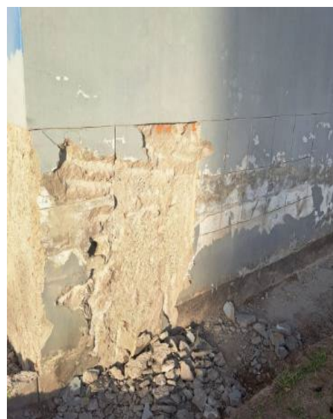
Labres de retiro de tarrajeo en mal estado en zona inferior del edificio administrativo.
