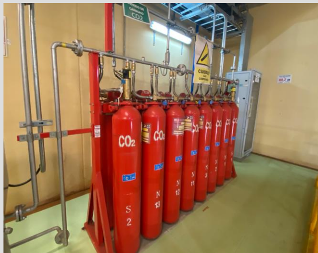
Sistema de extinción CO2 en generador Etapa 2
