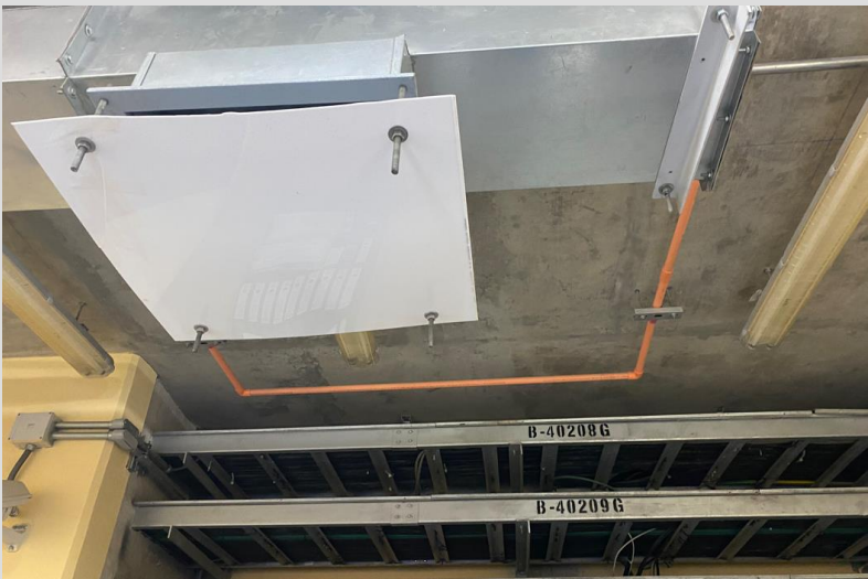
Sistema de aspiración por aire en centro de control
