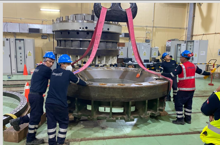
Estructura de turbina actual desmontada
