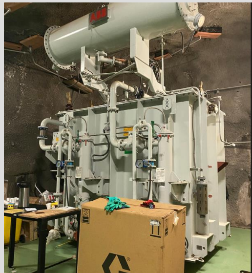
Transformador en Stand by en Etapa 2
