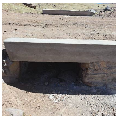
Trabajos realizados a los alcantarillados de la vía, recuperando su condición de operatividad.
