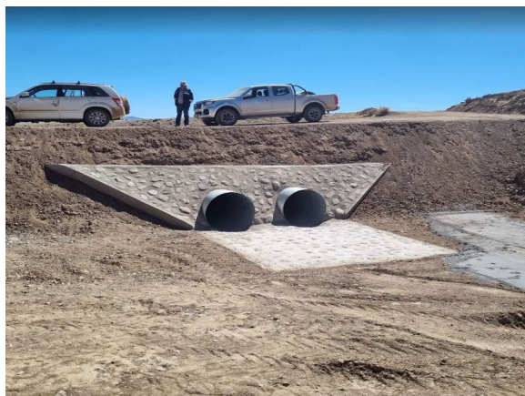
Pontón con alcantarilla construida en zona de quebrada, que impedía el paso de vehículos en época de lluvias.
