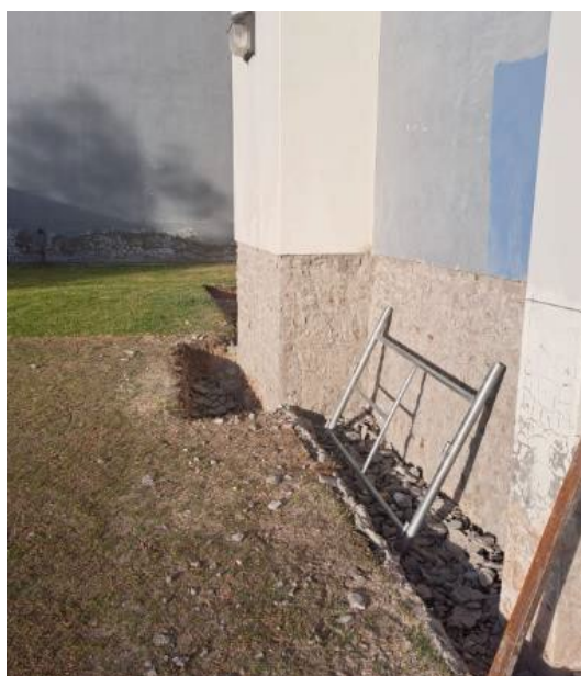
Labores de retiro del tarrajeo en mal estado y excavaciones para proceso de impermeabilización en base de estructura.
