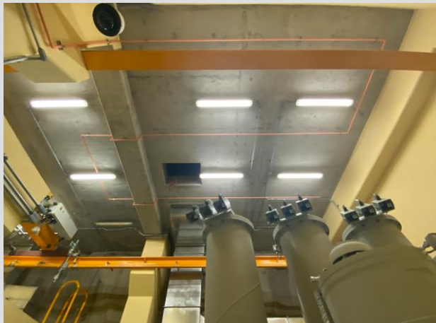
Sistema de aspiración por aire en sala GIS
