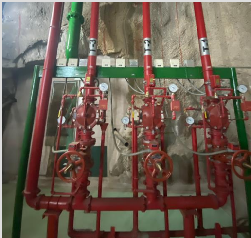
Manifold para el sistema de wáter spray en transformadores
