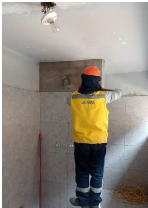
Trabajos de colocación de enchapado en cerámico en los SS.HH. de personal de mantenimiento.
