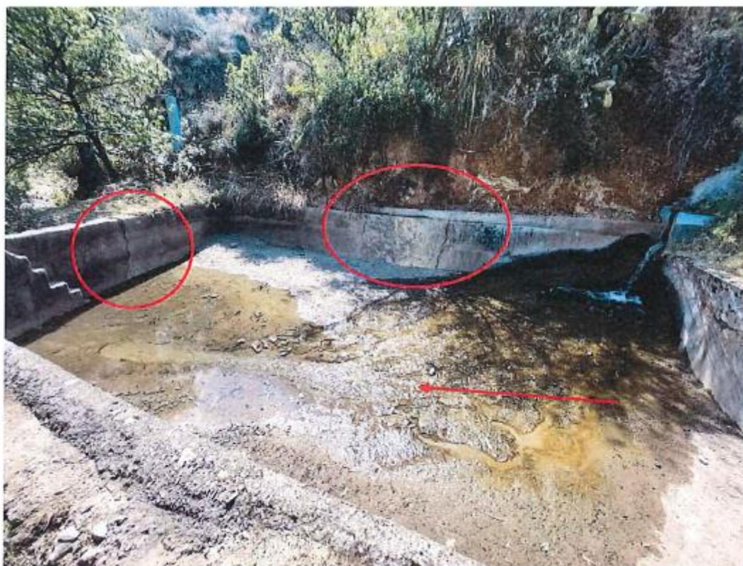
Figura 02: Reservorio presenta fracturas, grietas, rajaduras, en las paredes y piso. es un peligro constante para la población.
