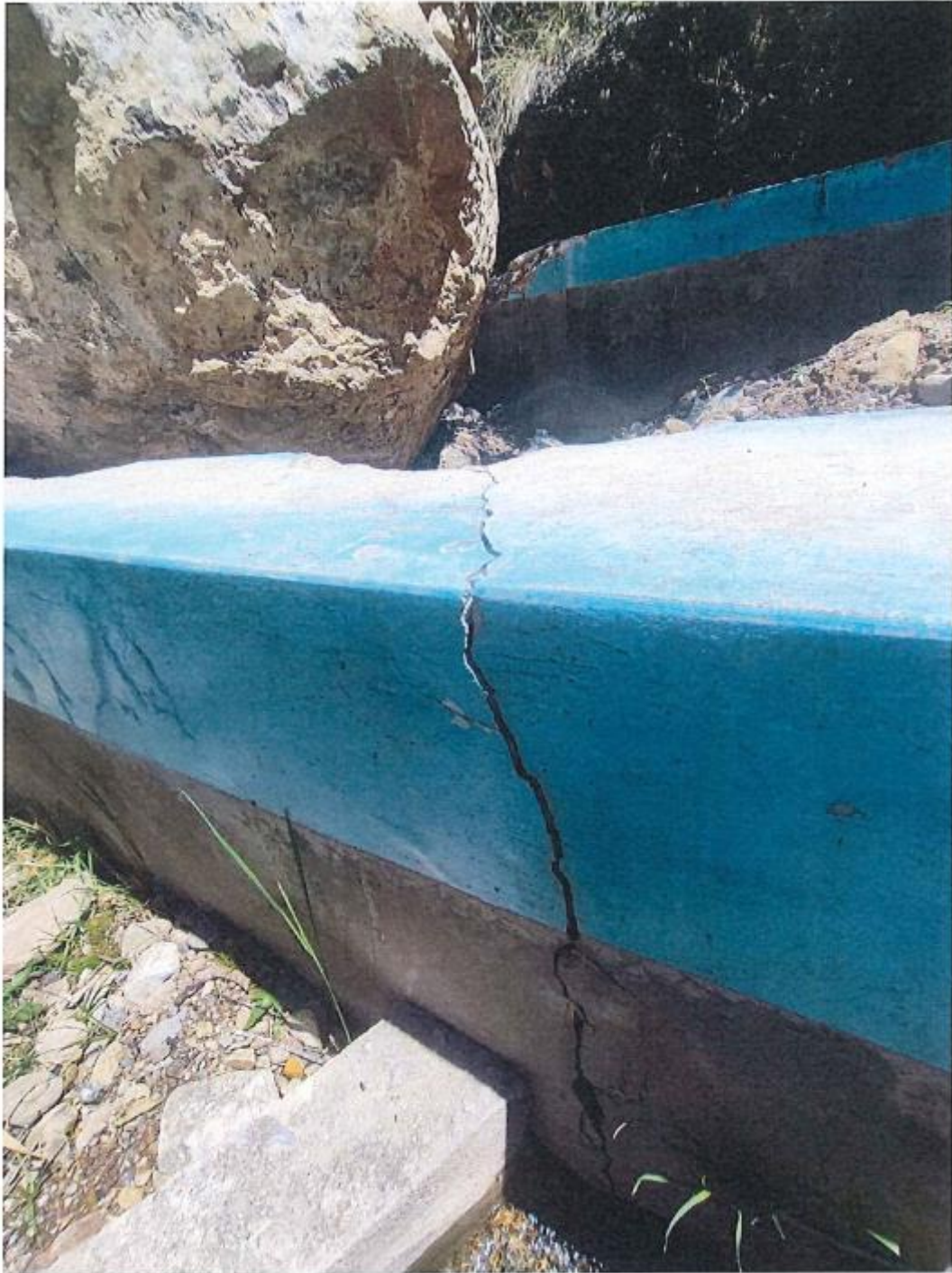
Imagen 01: se observa la caída de roca grande sobre la bocatoma que destruyó a la infraestructura)
