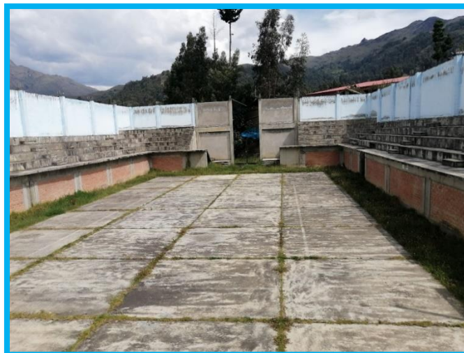
Fotografía 05. Se puede observar la vegetación que está comenzando a crecer por las partes que falta concretar la losa y por falta de sellado de las juntas en la losa existente, para ello se debe implementar estas necesidades para así evitar daños estructurales próximos.
