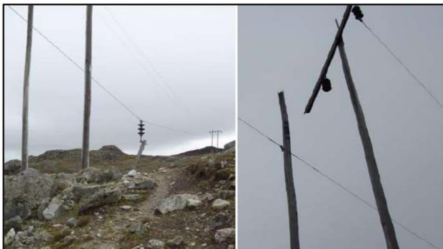
Fig. N° 04: Postes de madera de media tensión deteriorados
