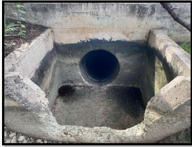
Imagen N°1: Punto de captación de agua en la zona más elevada del terreno
