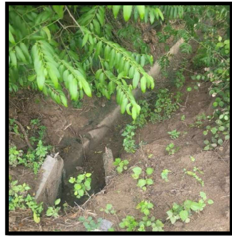
Imagen N°3: Canal para alimentación de reservorio de riego en mal estado - Anexo Hualtaco
