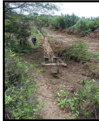
Imagen N°2: Ramal que nace de canal principal que alimenta al reservorio
