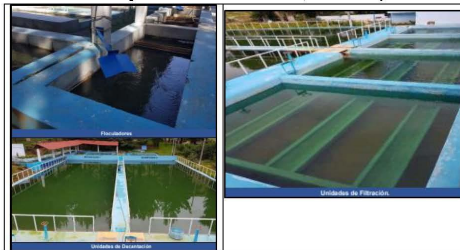
Ilustración 16: Vista fotográfica de la batería de los floculadores, 2 decantadores y 4 filtros
