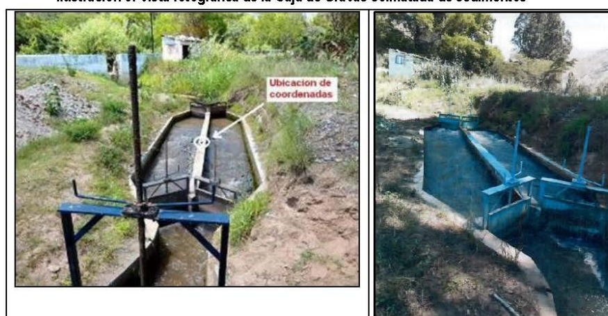
Ilustración 5: Vista fotográfica de la Caja de Gravas colmatada de sedimentos
