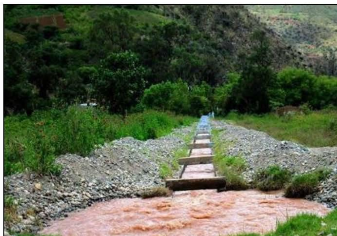
Ilustración 7: Vista fotográfica del Tramo de canal entre bocatoma y presedimentadores, se observa a los costados el material después de una limpieza.
