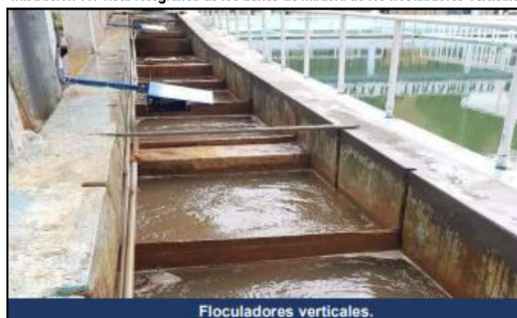
Ilustración 13: Vista fotográfica de los baffles de madera de los floculadores verticales
