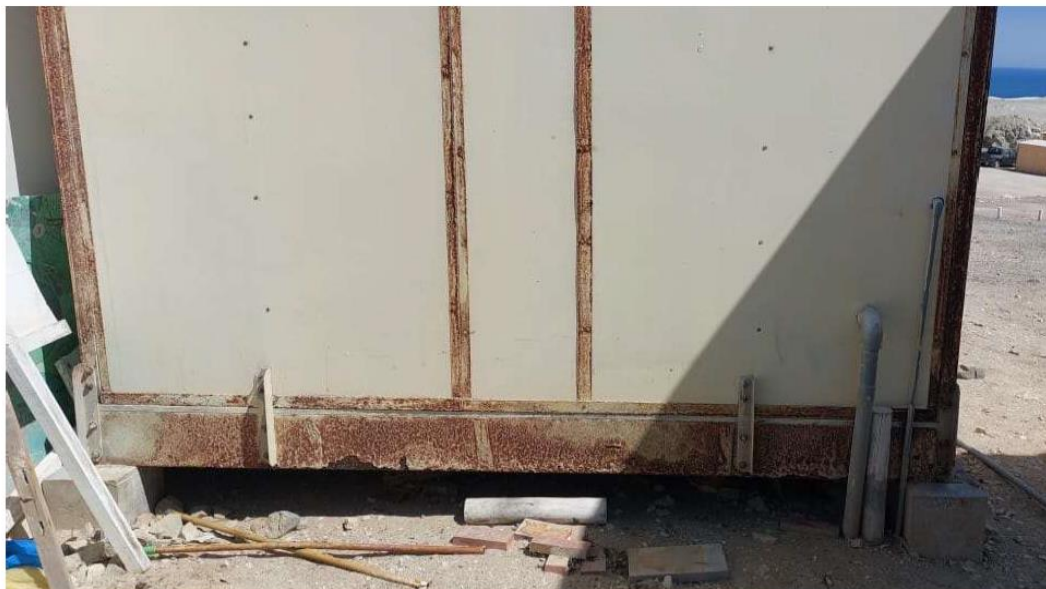
Foto 05: Base metálica de los módulos con oxido notorio.
