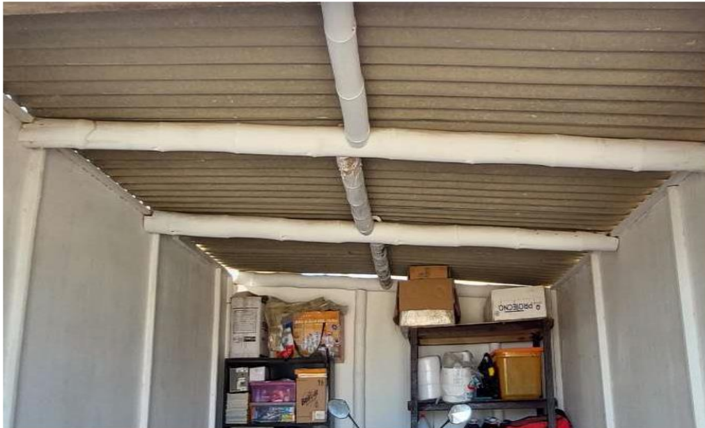
Foto 08: Interior de la cochera con armazón de caña Guayaquil con paredes de triplay desprendiéndose en la parte posterior.
