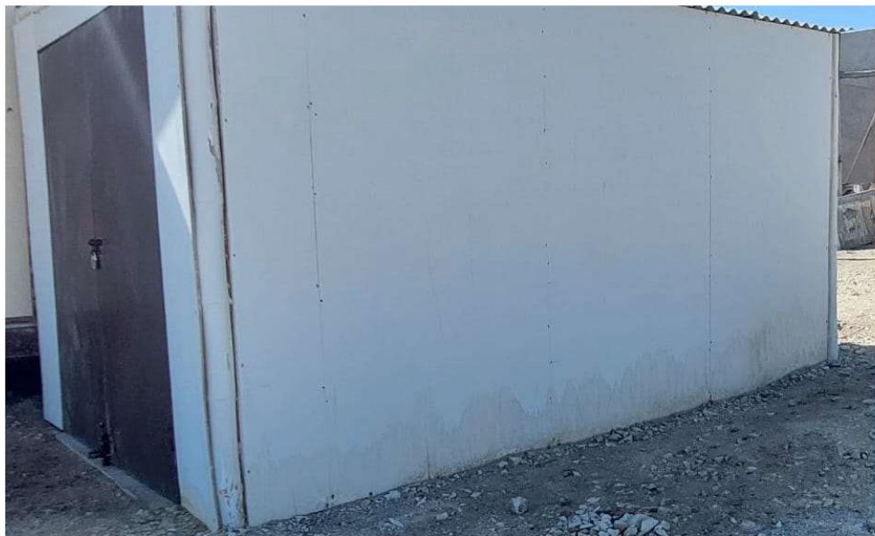
Foto 07: Estado actual de la cochera, paredes de triplay húmedas y en deterioro. Soporte de la estructura de caña Guayaquil con signos de deterioro.
