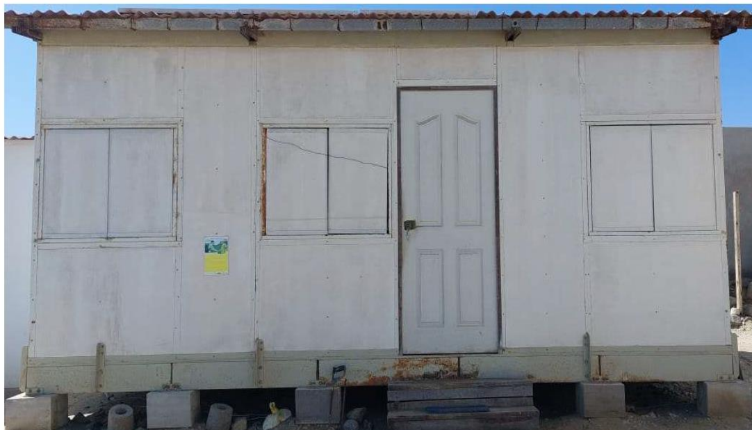
Foto 03: Estado actual de los módulos del P.V.C: de punta San Juan: ventanas en deterioro y con oxido, techo con signos de deterioro, parantes de soporte con signos de oxido, etc.
