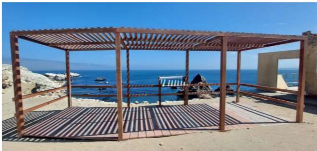
Foto 13: Mirador turístico de Lobos Marinos con la pintura protectora deteriorada.
