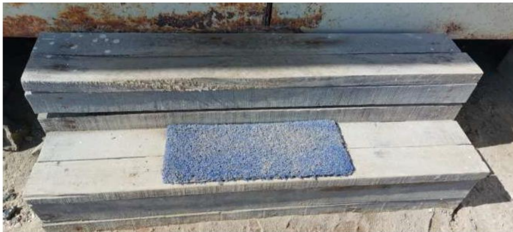
Foto 09: Estado actual de las gradas de ingreso a los módulos: necesita cambiarse.
