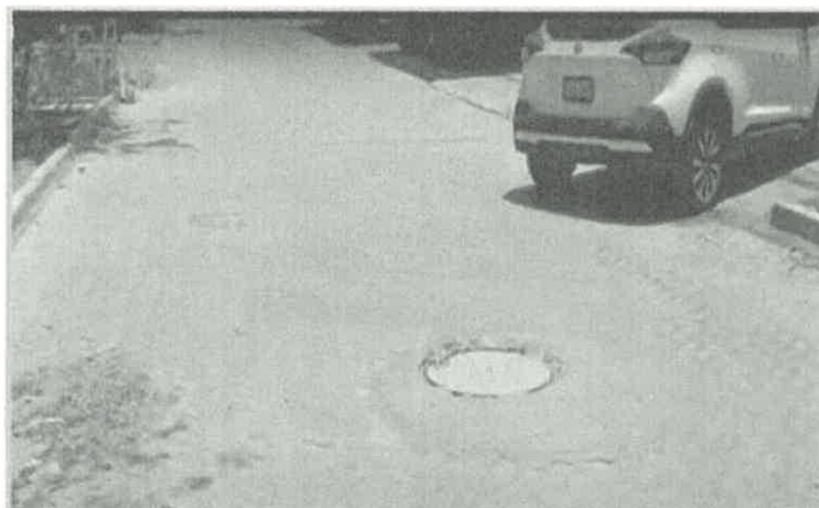
CALLE B DESGASTE DE PAVIMENTO Y BACHES
