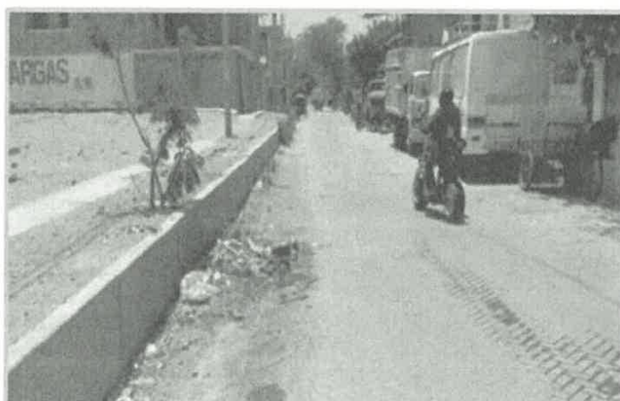
CALLE A DESGASTE DE PAVIMENTO Y BACHES
