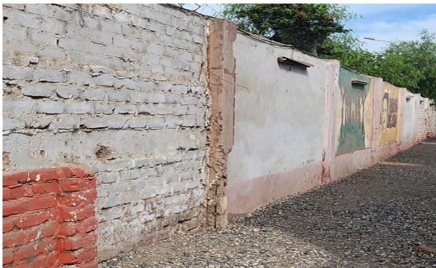
Imagen N°17: Cerco Perimétrico Vista Interior: Cerco en zona de Avenida El Carmen, se observa a la columna con concreto totalmente desprendido, el acero corroído y ausencia de viga de confinamiento, en muy mal estado de conservación.
