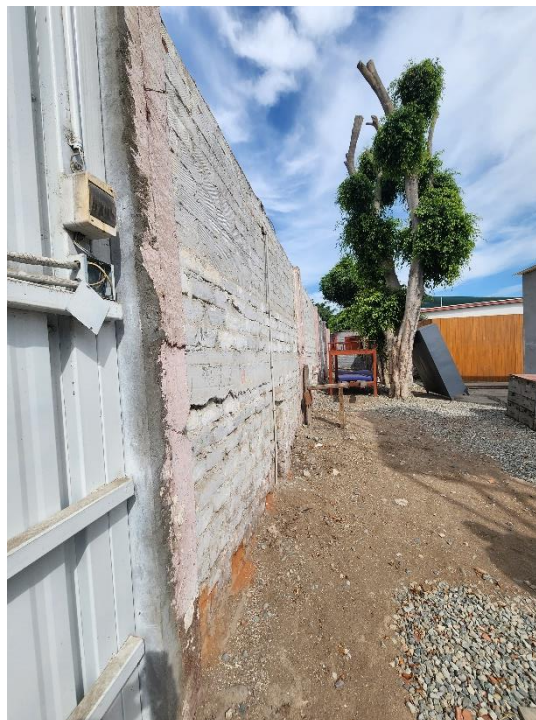
Imagen N°13: Cerco Perimétrico Vista Interior: Cerco en zona de Avenida El Carmen, en muy mal estado de conservación, con inclinación y ausencia de viga de confinamiento.
