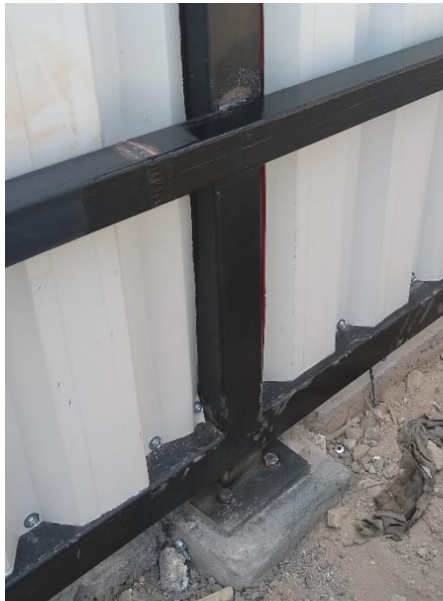
Esquema de anclaje de plancha de Aluzinc y tubo metálico 3"x3" e=3 mm., con pernos autoroscantes
