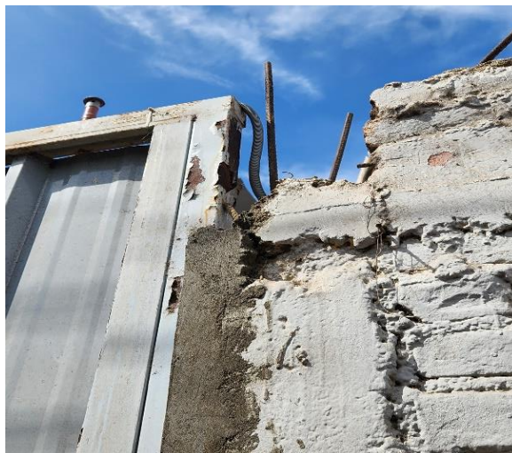
Imagen N°11: Cerco Perimétrico Vista Exterior: Cerco en zona de Calle Camere, en muy mal estado de conservación, se observa la columna con concreto desprendido y rajado; el acero oxidado y ausencia de viga de confinamiento.
