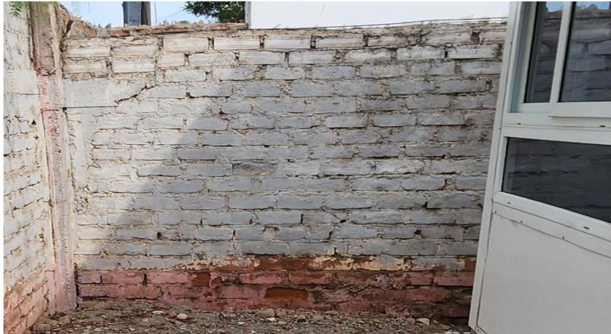
Imagen N°18: Cerco Perimétrico Vista Interior: Cerco en zona colindante a edificio multifamiliar, en muy mal estado de conservación, muro con ladrillos carcomidos y ausencia de viga y columnas de confinamiento.
