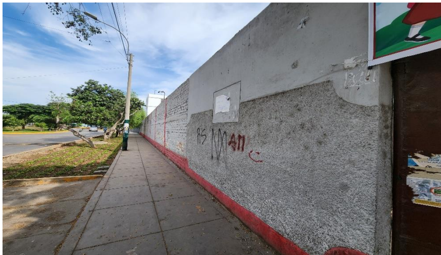
Imagen N°16: Cerco Perimétrico Vista Exterior: Cerco en zona de Avenida El Carmen, se observa al muro con inclinación y ausencia de viga de confinamiento, en muy mal estado de conservación.
