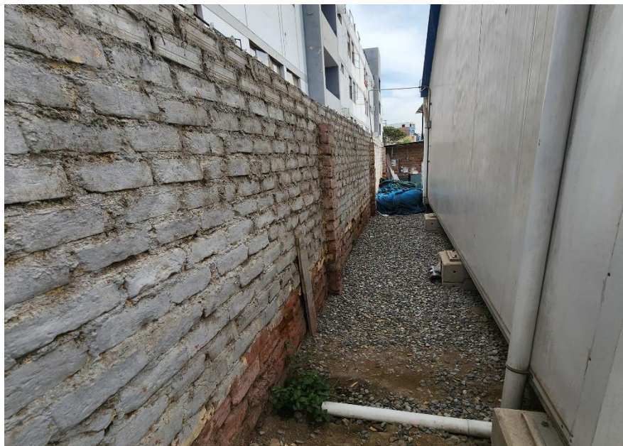
Imagen N°19: Cerco Perimétrico Vista Interior: Cerco en zona colindante a edificio multifamiliar, en muy mal estado de conservación, ausencia de viga y columnas de confinamiento.
