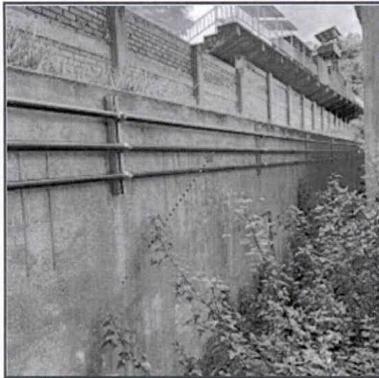
red de tubería de petróleo (tubería de fierro negro) recorrido hacia la boca de llenado de combustible.
