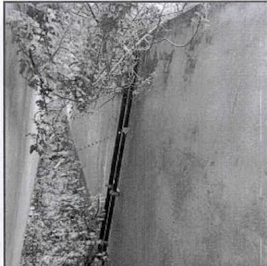
red de tubería de petróleo (tubería de fierro negro) tubería para el llenado de combustible hacia el tanque el tanque soterrado de petróleo.
