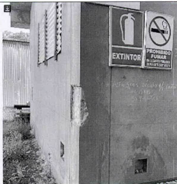
Figura 44. Vista de inspección del sector E3. En la imagen se observa la columna dónde anteriormente se realizó el ensayo de esclerometría.
