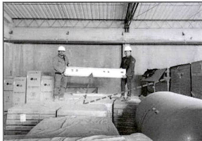
Paneles de cabeceros de la marca LM MEDICAL, correspondiente al sistema de gases medicinales.
