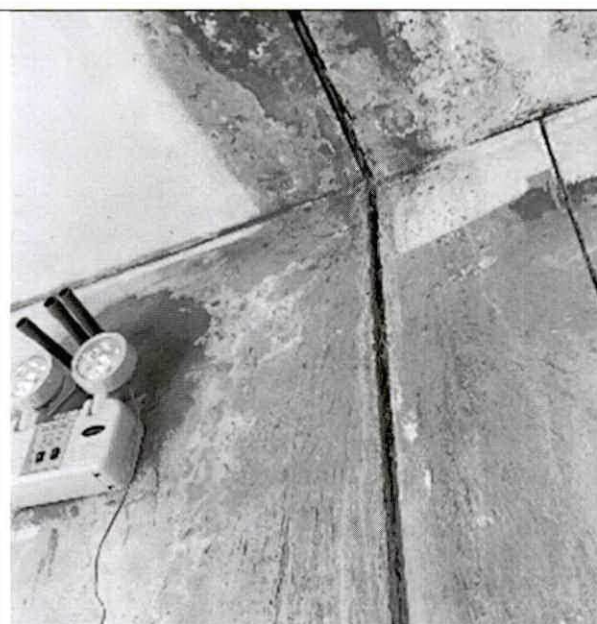
Figura 34. Vista interna de junta sísmica entre sectores Sector E1 y E2. En la imagen se observa filtración de las precipitaciones pluviales y presencia humedad de moho
