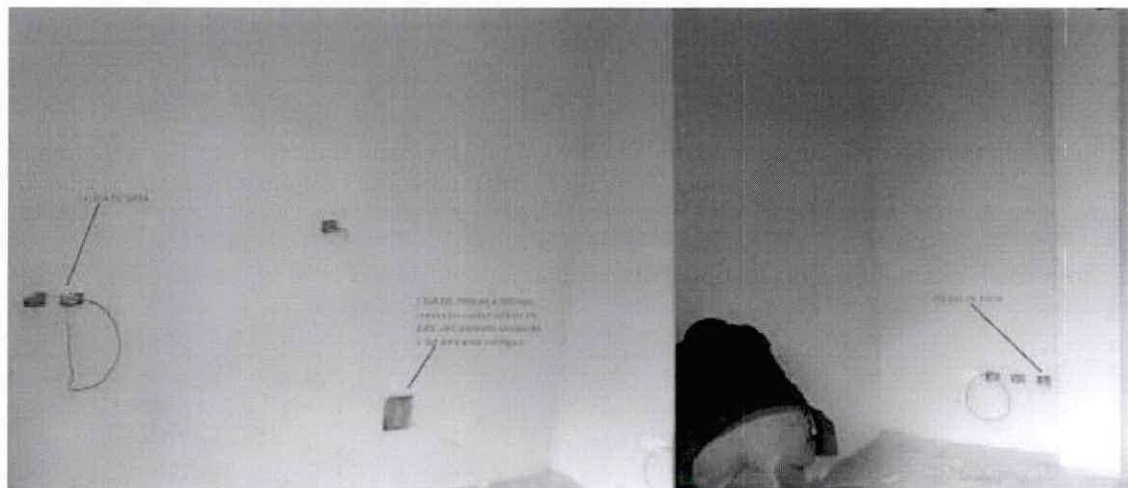
Figura 12 – Caja de Paso intermedia, 300mmx300mm, no encontrada en ningún plano
