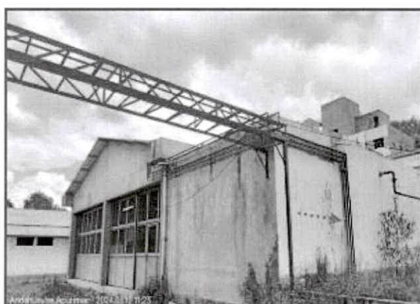
red de tubería de GLP color amarillo, recorrido desde el tanque de GLP hacia las calderas, recorrido a través de canaleta por piso y sube por muro.
