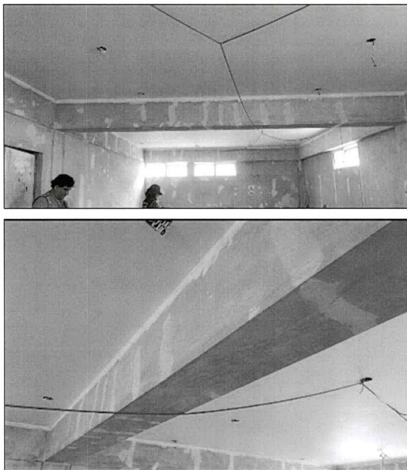
Figura 11. Vista de viga peraltada interior - Sector A2. Se observa fisuras resanadas en las vigas peraltadas y placas de concreto.
