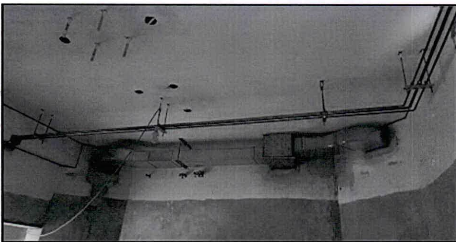
IMAGEN N° 3. Tuberías de cobre y ductería en los techos de la sala.
