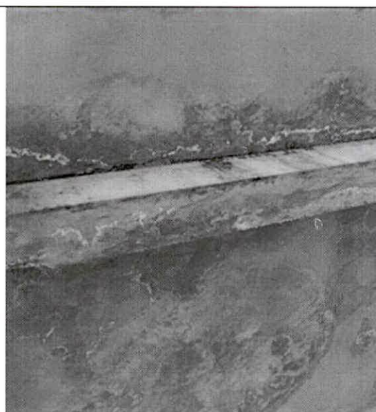
Figura 39. Vista inspección interior del sector E1. Se observa presencia de humedad, moho, eflorescencia en viga y losa de techo.
