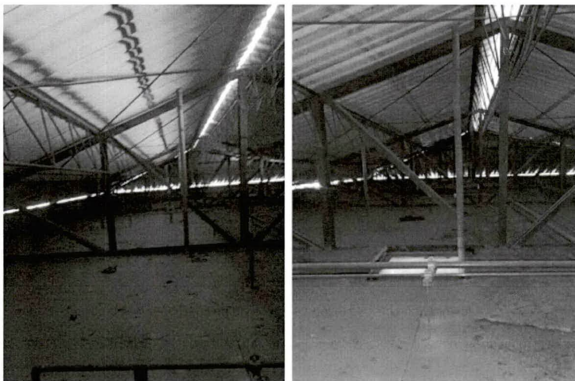
Figura 2 – Tijerales encontrados en los techos de los Bloque A1 y A2
