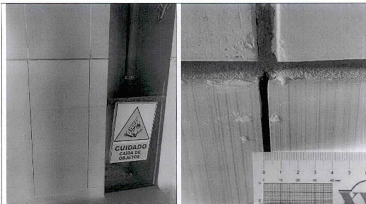
Figura 26. Vista interna de junta muros tabique y columna de concreto en el sector C1. La junta tiene 5 mm de ancho aproximadamente.
