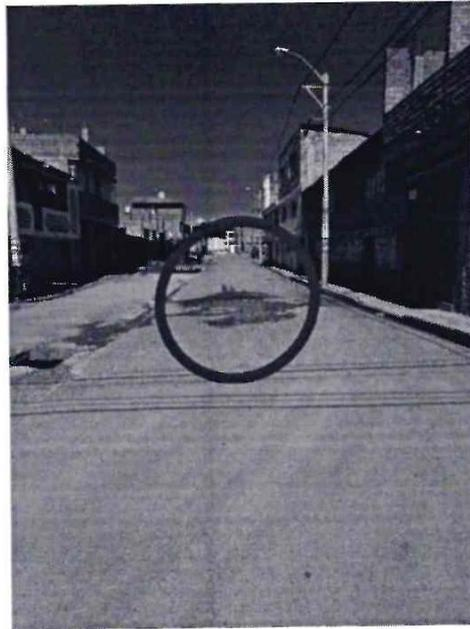
Estado Situacional del Jr. Túpac Amaru: La vía presenta grietas, hundimientos y desgaste del pavimento. No cuenta con señalización, lo que afecta la seguridad y hace inadecuado el tránsito peatonal.
