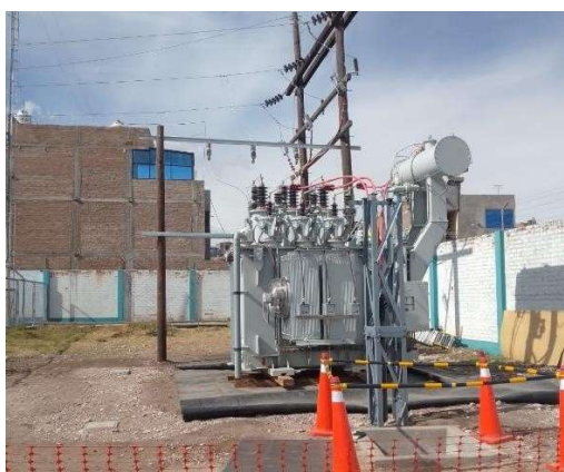
Figura N°01: Transformador de Potencia de 5/6.5 MVA- 33/13.2 kV Subestación Eléctrica Chupaca
