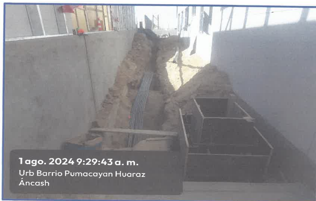
IMAGEN N° 20: Vista de los trabajos de tendido de tubería para Instalaciones Eléctricas, alimentador de medidor hacia tableros, trabajos inconclusos, así como también se parecían las cajas de registro de Drenaje Pluvial en proceso de construcción.
