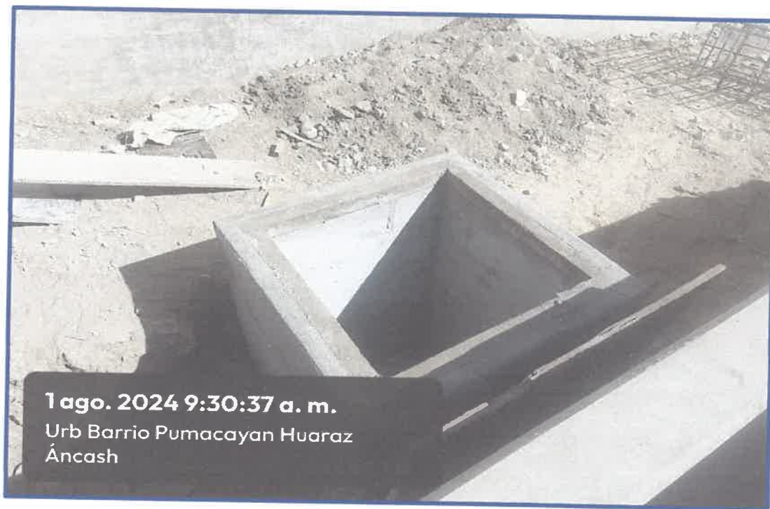
IMAGEN N° 35: Vista de los trabajos ejecutados en cajas de registro de drenaje pluvial y drenaje sanitario.
