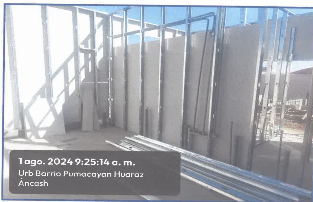
IMAGEN N° 27: Vista de los trabajos en tabiquería seca, en el bloque "C", trabajos inconclusos, se aprecian también los trabajos de Instalaciones Eléctricas e Instalaciones Sanitarias.
