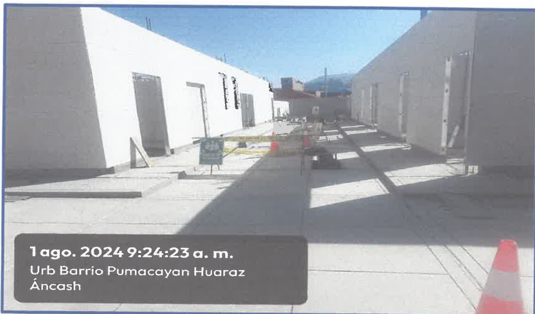
IMAGEN N° 18: Vista de los trabajos de Tabiquería Seca en los Bloques "C" y "D", así como también las veredas y rampas ejecutadas en el perímetro de dichos bloques. Se aprecia también la ejecución de trabajos de cajas de registro de drenaje pluvial.
