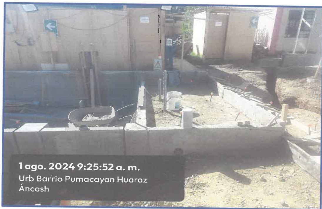
IMAGEN N° 29: Trabajos inconclusos en el bloque "F", vista de los trabajos ejecutados hasta la fecha (muros de contención, así como trabajos de relleno y compactado).
