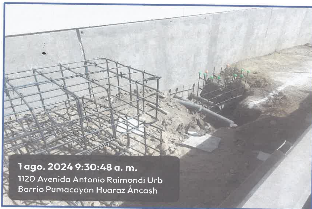
IMAGEN N° 37: Vista de los trabajos ejecutados en cajas de registro de drenaje pluvial y drenaje sanitario.
