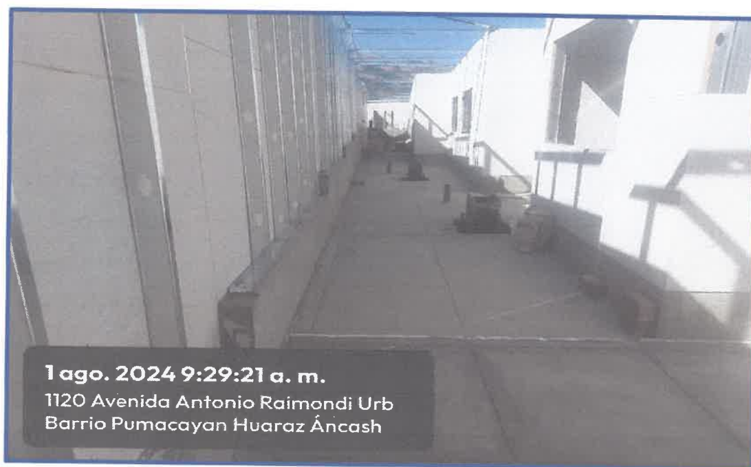
IMAGEN N° 08: Vista de los trabajos de tabiquería seca (Muro Perimetral), trabajos inconclusos. Se aprecia también los trabajos de tabiquería seca en uno de los ejes del Bloque "A"; se evidencia el vaciado de concreto en rampas y veredas de acceso ubicadas en uno de los lados del Bloque "A".
