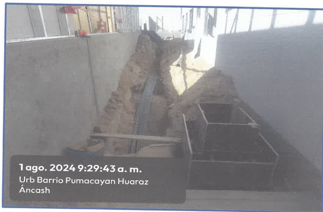
IMAGEN N° 36: Vista de los trabajos ejecutados en cajas de registro de drenaje pluvial y drenaje sanitario.
