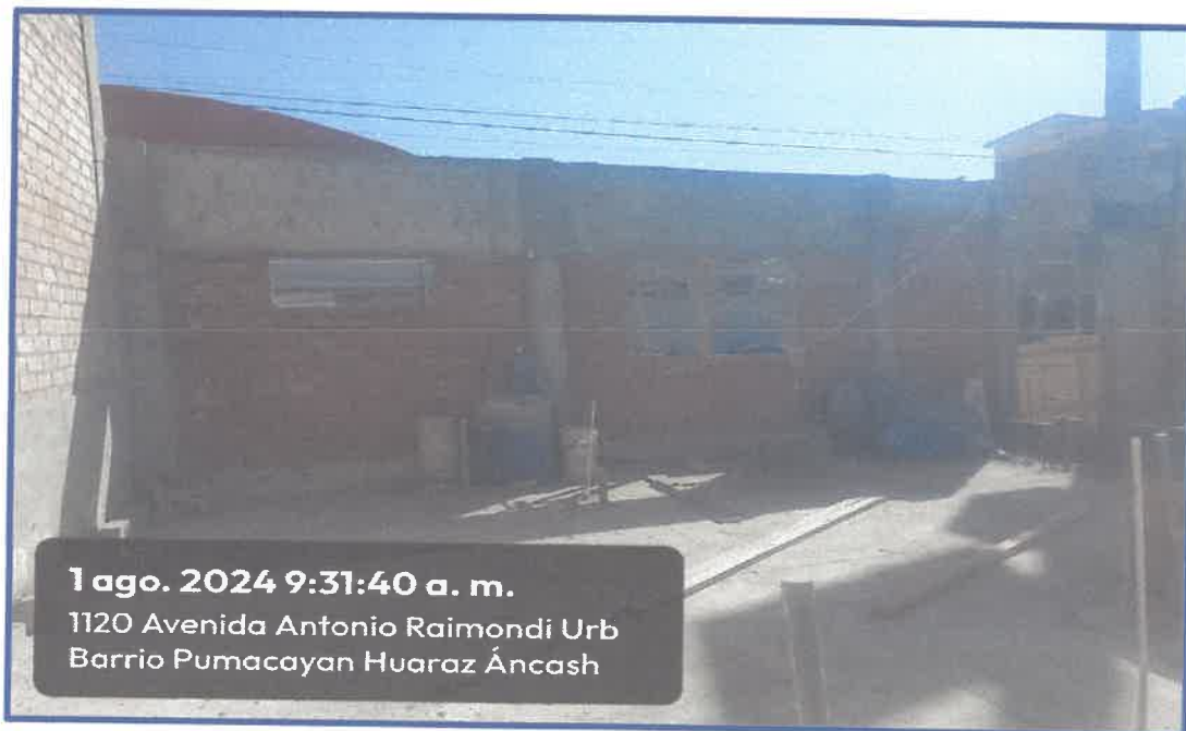
IMAGEN N° 32: Trabajos inconclusos en el bloque "B", vista de los trabajos ejecutados hasta la fecha (muro de albañilería, así como los trabajos de instalaciones Sanitarias, vaciado de losas de concreto - falso piso).
