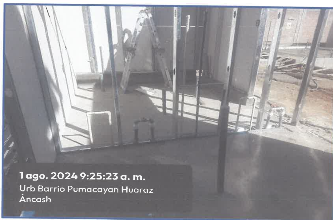
IMAGEN N° 28: Vista de los trabajos en tabiquería seca, en el bloque "C", trabajos inconclusos, se aprecian también los trabajos de Instalaciones Sanitarias (Agua Caliente, Agua fría y desagüe).
