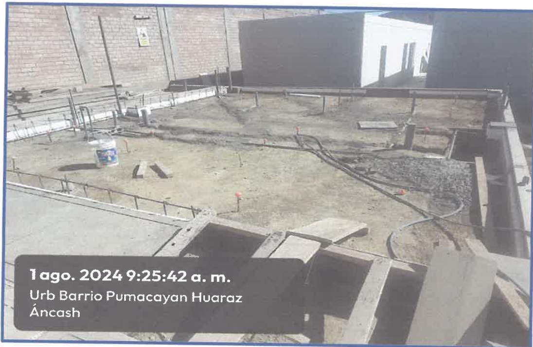
IMAGEN N° 31: Trabajos inconclusos en el bloque "E", vista de los trabajos ejecutados hasta la fecha (muros de contención, así como trabajos de relleno y compactado).
