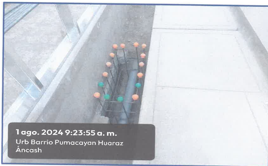
IMAGEN N° 38: Vista de los trabajos ejecutados en cajas de registro de drenaje pluvial y drenaje sanitario.
