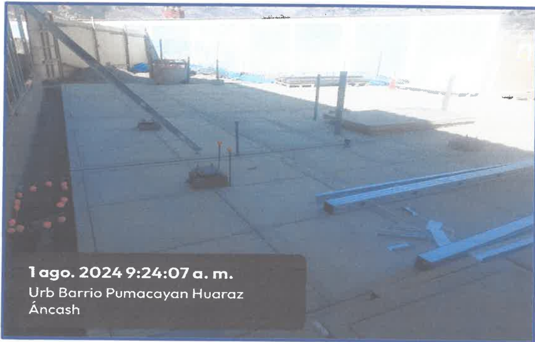
IMAGEN N° 17: Vista de las losas de concreto (Parte Posterior a los Bloques "C" y "D", así como en el área del Tanque Elevado). Se aprecian también las cajas de registro de drenaje pluvial en proceso de construcción.
