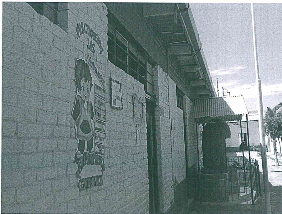
Foto N° 01: Autoconstrucción carece de sistema estructural aula refaccionada.
