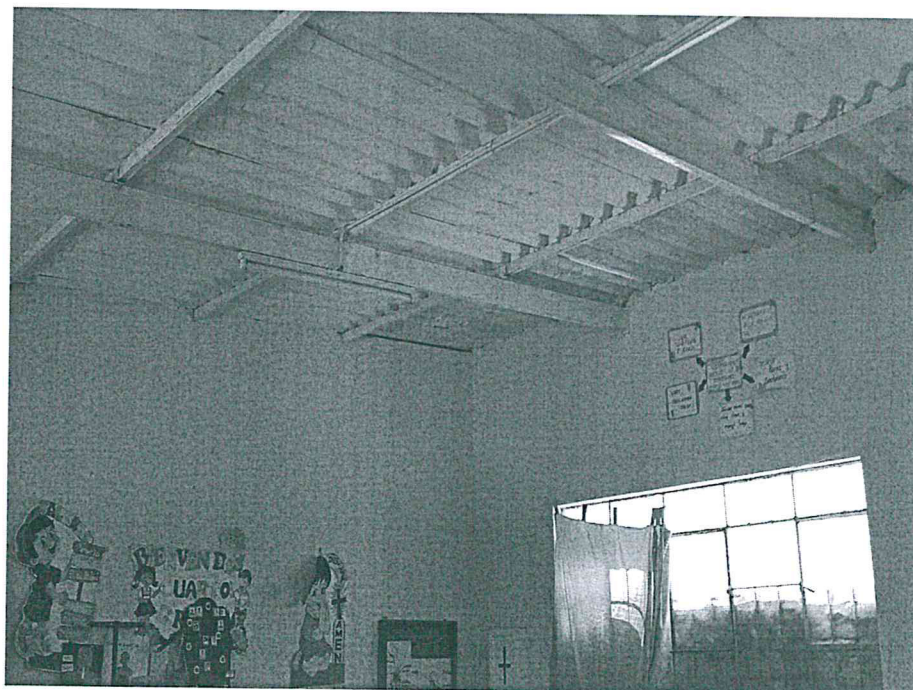
Foto N° 03: Autoconstrucción sin ningún tipo de sistema sísmico ni estructural presencia de humedad.
