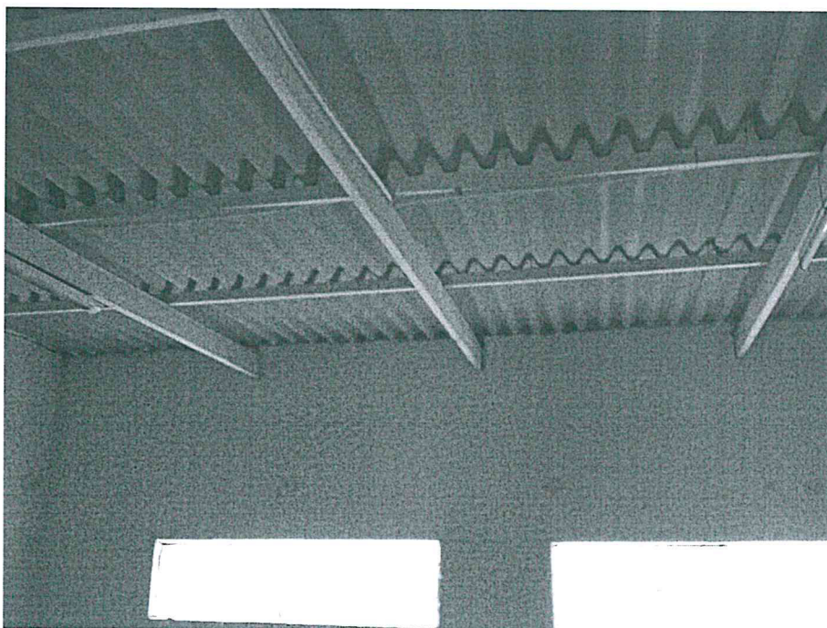
Foto N° 01: Autoconstrucción carece de sistema estructural aula refaccionada.
