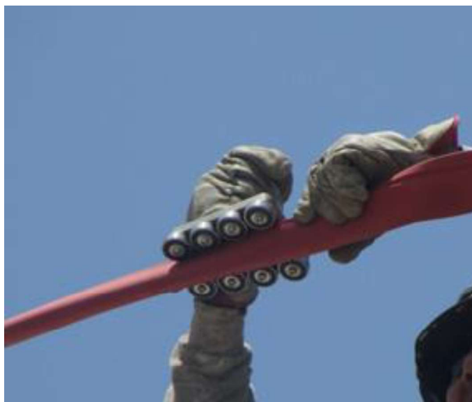
Instalación de cubiertas con equipo de fijación
