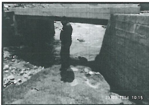
Imagen N° 02: (En la presente imagen se puede observar la estructura en deterioro) El peralte de la superestructura es insuficiente para la luz necesaria del puente.
