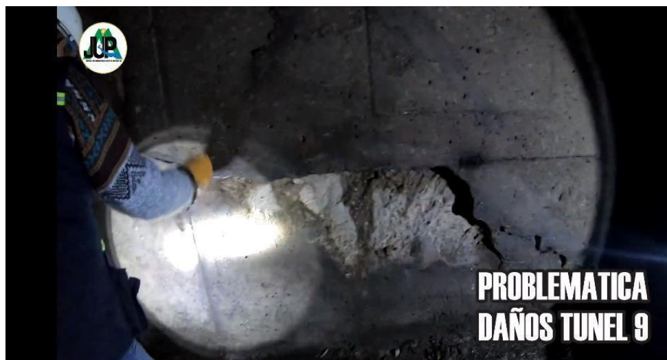
Figura.1.8-2 Desprendimiento en los hastiales del Túnel 9
