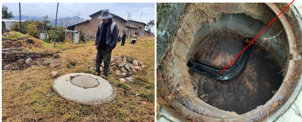
Imagen: Vista de los buzones y media caña en estado regular
