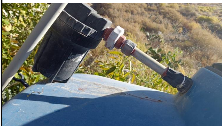
Instalación de una base fenólica para la base del tanque, cambio de tuberías, cambio de tanque y accesorios.
