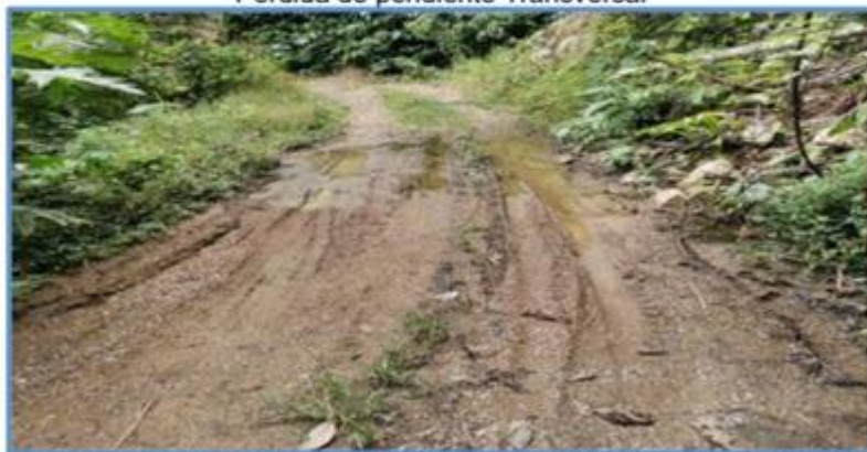
Fotografía N°04: Perdida de pendiente transversal y ahuellamiento Pérdida de pendiente Transversal
