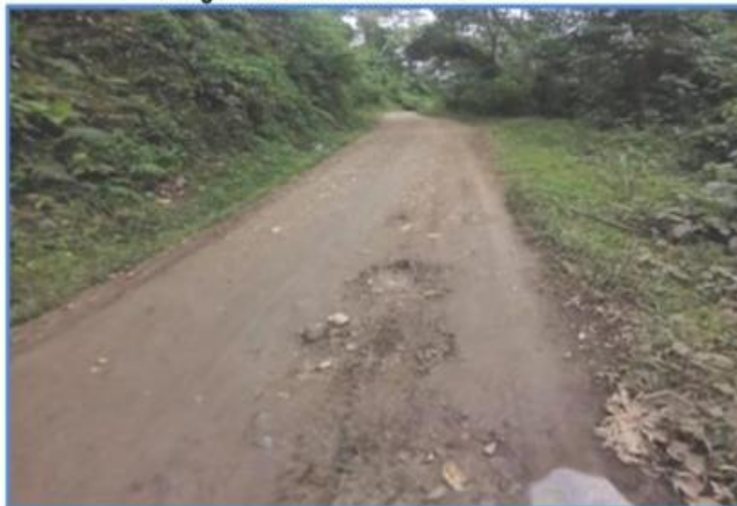
Fotografía N°02: Ondulaciones de la vía
