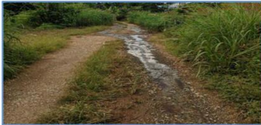
Fotografía N° 06: Cunetas coberturadas de malesas
