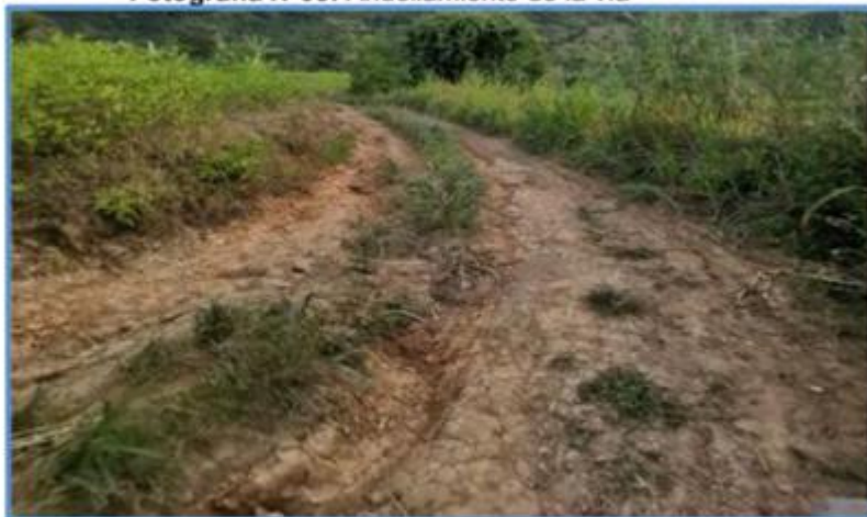
Fotografía N°03: Ahuellamiento de la vía
