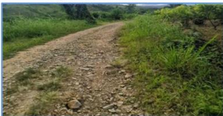
Fotografía N°05: Surcos de erosión en la vía
