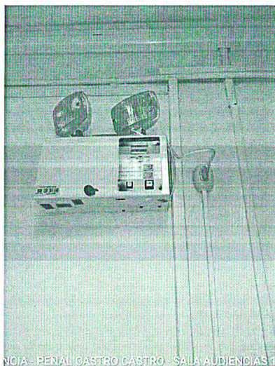
Imagen 27 – Luminaria de emergencia conectada a punto de circuito de tomacorriente.
