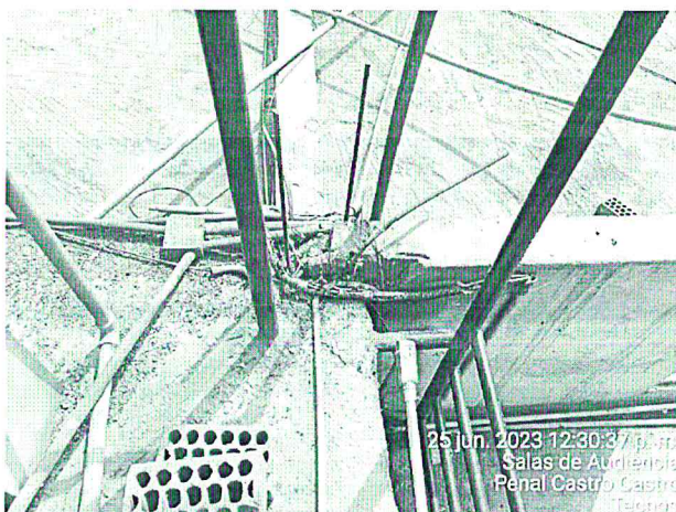
Imagen 32- Canalizado inadecuado, cables expuestos
