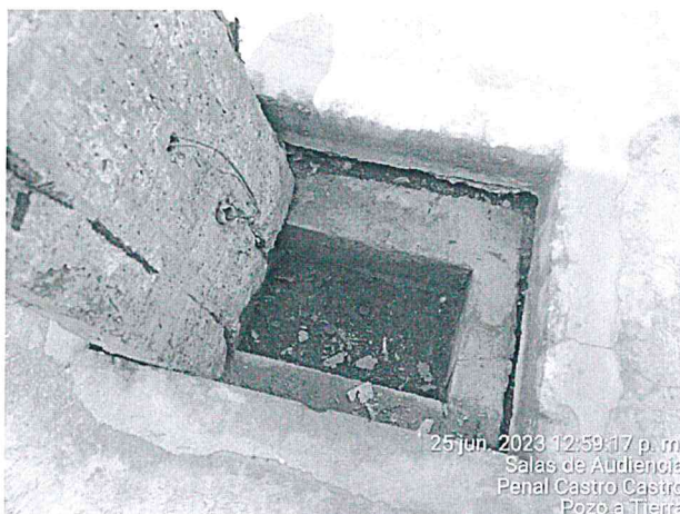
Imagen 35 – Se debe de realizar mantenimiento correctivo de pozo a tierra, no se aprecia cableado ni conexión al sistema.
