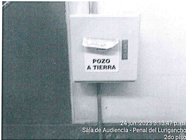
Imagen 83 – Falta realizar una correcta identificación de caja equipotencial
