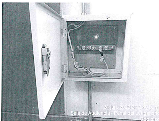
Imagen 84 – Caja equipotencial no conecta con ningún cable del sistema eléctrico existente.
