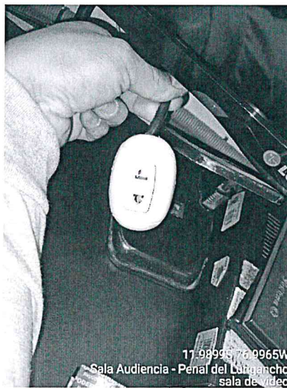
Imagen 53 – Tomacorriente no normado con cableado expuesto sin conexión a tierra
