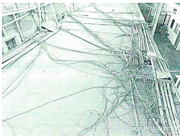
Imagen 82 – Cajas de pase con conexiones eléctricas expuestas, tuberías tipo PVC en mal estado, estas deben ser del tipo EMT
