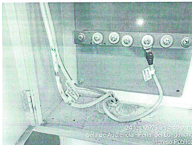
Imagen 86 – Caja equipotencial no conecta con ningún cable del sistema eléctrico existente.
