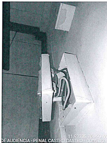
Imagen 65 – Tomacorriente mal fijado.
