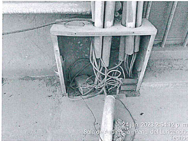
Imagen 79 – Cajas de pase con conexiones eléctricas expuestas, tuberías tipo PVC en mal estado, estas deben ser del tipo EMT.
