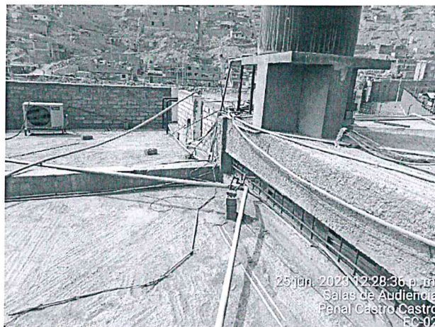
Imagen 32- Canalizado inadecuado, cables expuestos
