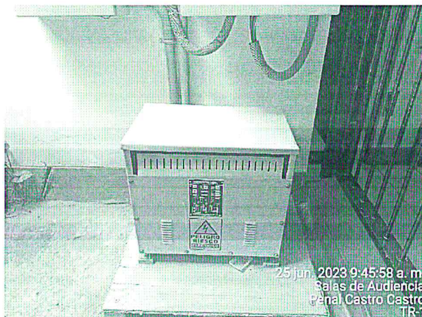
Imagen 07 – Transformador – Debe de cambiarse base, realizar un correcto anclaje, actualmente se encuentra sobre base de madera, riesgo eléctrico.
