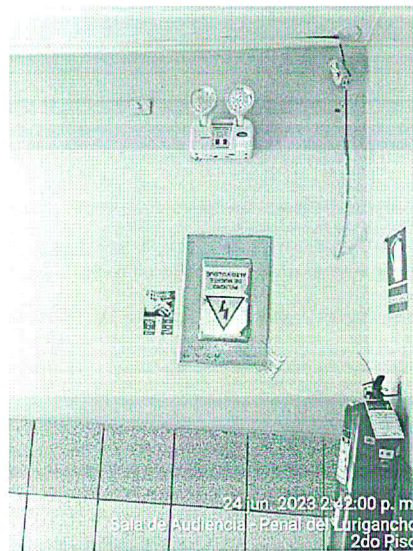
Imagen 74 – Luminaria de emergencia conectada a punto de circuito de tomacorriente.
