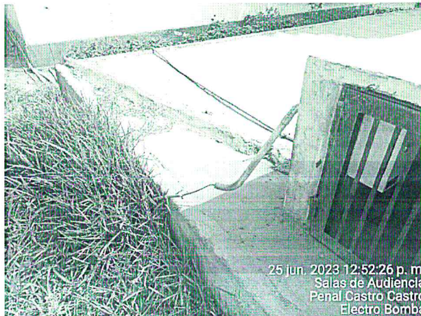
Imagen 34– Canalizado de alimentación eléctrica del sistema de bombeo en mal estado, no cuenta con cable a tierra.
