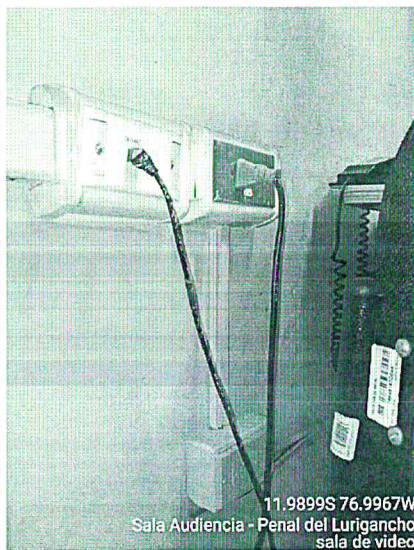
Imagen 54 – Tomacorriente indica que es estabilizado sin embargo se alimenta de circuito normal
