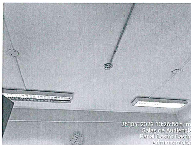
Imagen 87 – Sistema de Detección de Humos inoperativo
