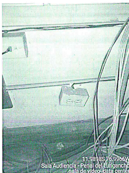
Imagen 63 – Tomacorriente mal fijado, cableado expuestos.
