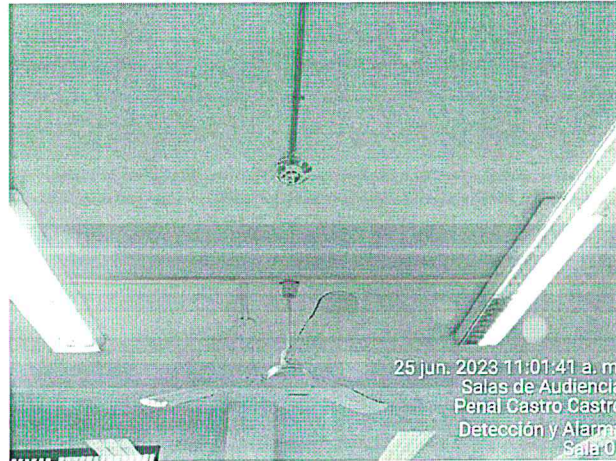
Imagen 87 – Sistema de Detección de Humos inoperativo
