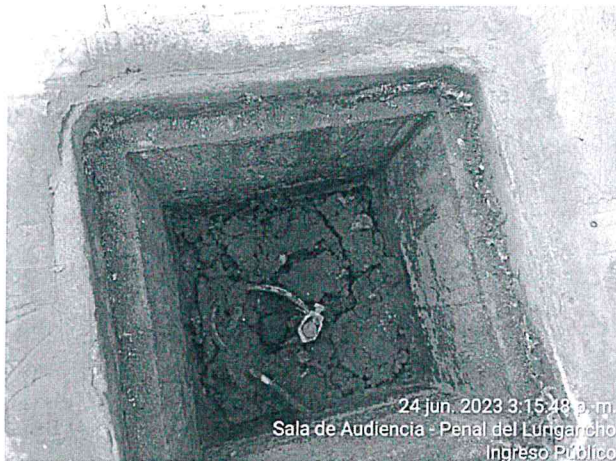
Imagen 87 – Pozos a tierra requieren mantenimiento correctivo.
