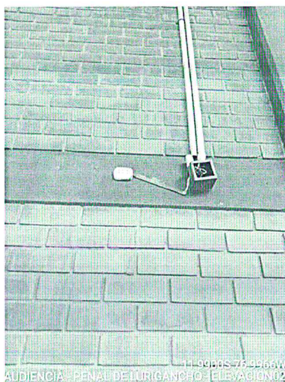
Imagen 55 – Tomacorriente en exterior con cableado expuesto, sin conductor a tierra y cable mellizo.
