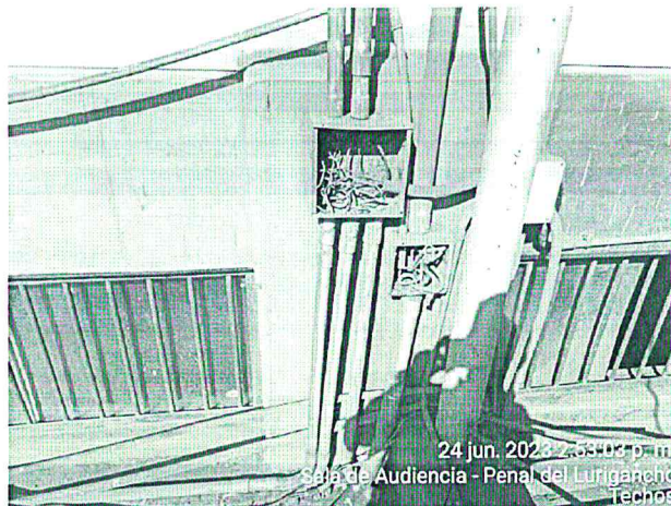
Imagen 77 – Cajas de pase con conexiones eléctricas expuestas, tuberías tipo PVC, estas deben ser del tipo EMT.
