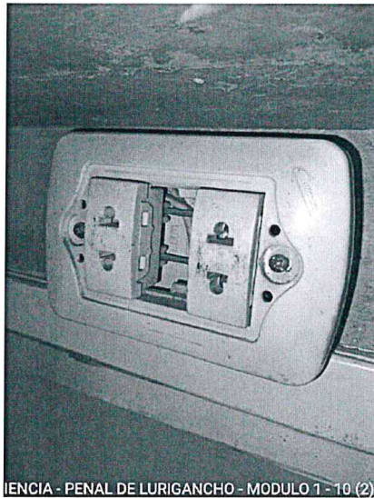
Imagen 64 – Tomacorriente sin placa de protección.
