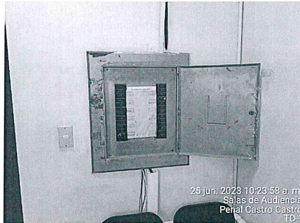
Imagen 09 – Tablero TD-1 – No cuenta con rotulados, ni leyenda ni diagrama unifilar, tablero para cambio por uno nuevo.
