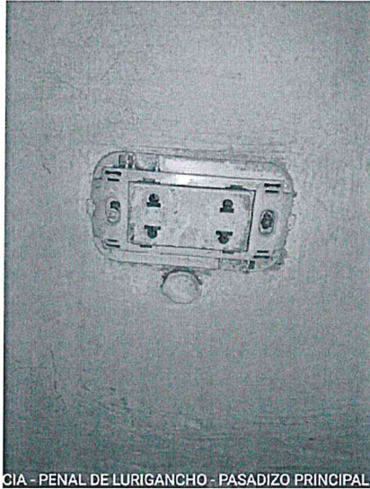
Imagen 68 – Tomacorriente sin placa.
