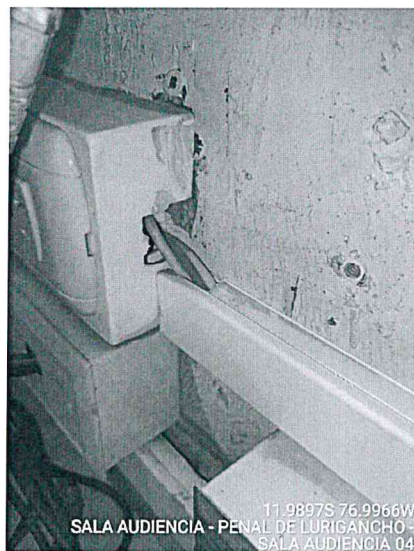
Imagen 61 – Tomacorriente con cableado expuesto.
