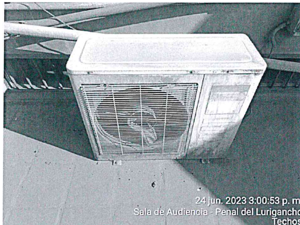
Imagen 72 – Equipo condensador inoperativo, vida útil cumplida, debe de ser reemplazado. Alimenta sala de audiencia.
