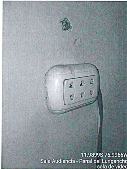
Imagen 52 – Tomacorriente no normado con cableado expuesto sin conexión a tierra
