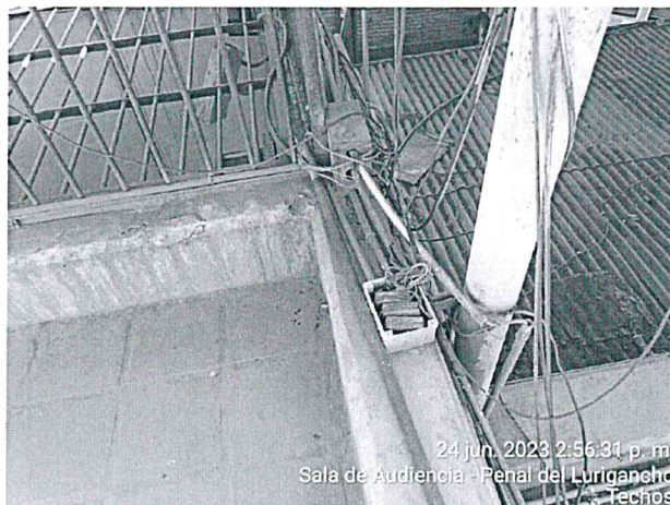
Imagen 80 – Cajas de pase con conexiones eléctricas expuestas, tuberías tipo PVC en mal estado, estas deben ser del tipo EMT.
