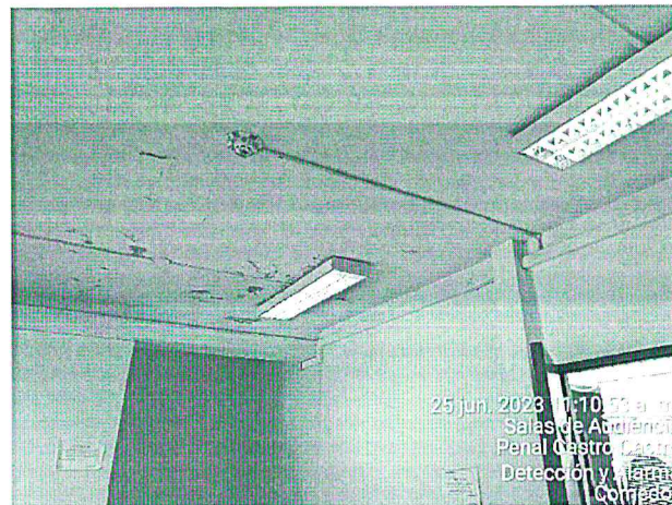
Imagen 87 – Sistema de Detección de Humos inoperativo
