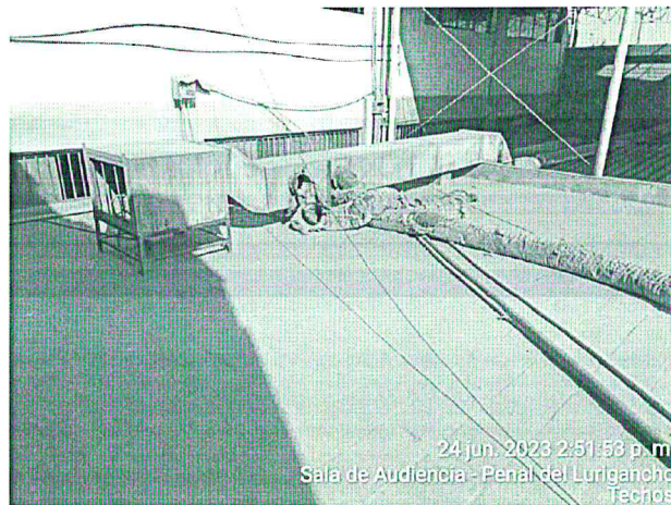
Imagen 70 – Equipo de inyección de aire en mal estado, inoperativo, debe de ser desmontado y puntos de inyección anulados.
