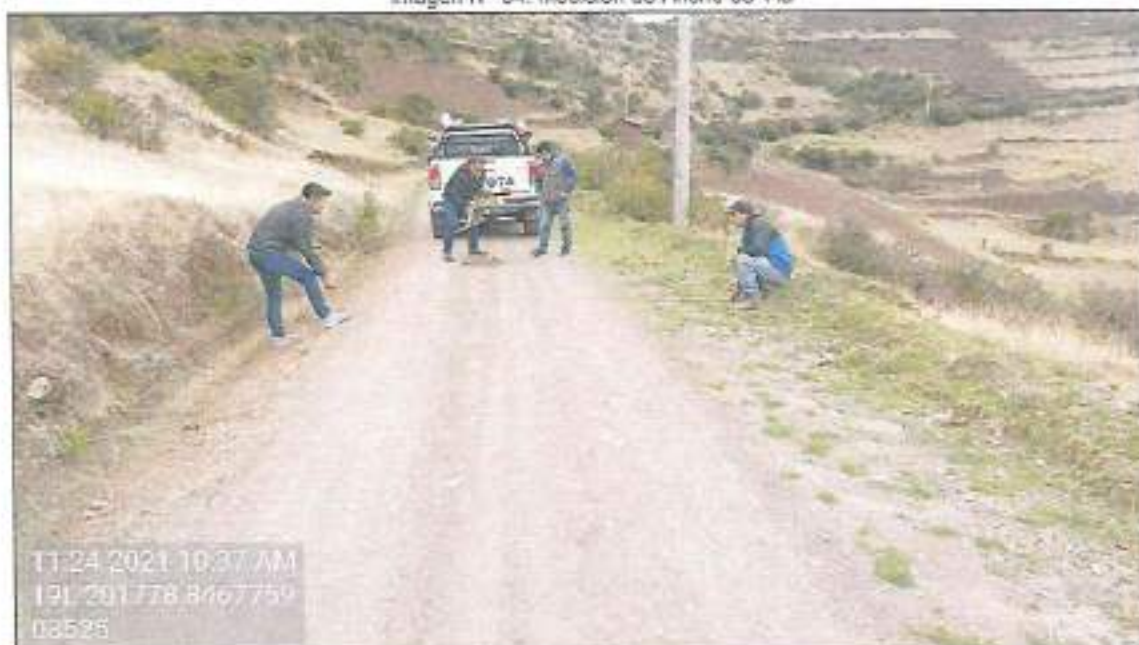
Imagen N° 04: Medición de Ancho de Vía
