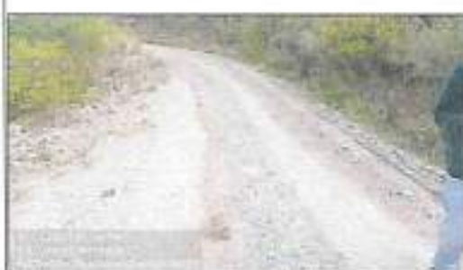
Foto 27: Daño en afirmado Progresiva 56+780
