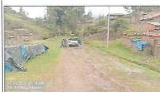
Foto 42: Daño en afirmado Progresiva 69+750
