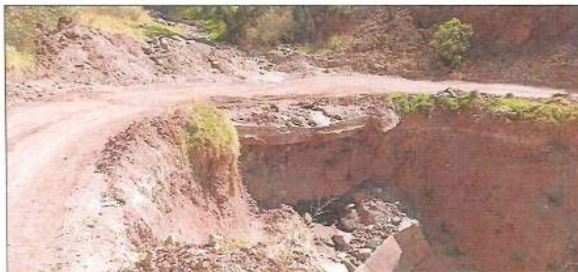
Imagen N°05: Badén parcialmente destruido 55+980
