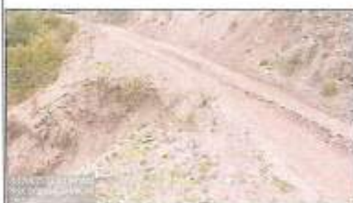
Foto 39: Daño en afirmado y pérdida de plataforma Progresiva 67+820
