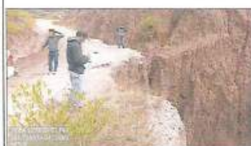
Foto 28: Punto de control - Perdida de plataforma Progresiva 57+260
