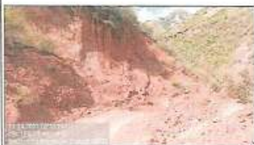
Foto 25: Daño en afirmado y derrumbe Progresiva 55+440
