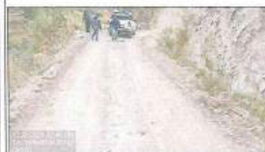
Foto 34: Daño en afirmado Progresiva 62+900
