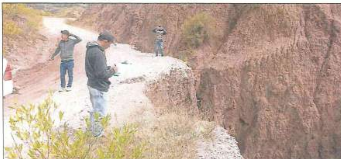
Imagen N°04: Daño en afirmado y derrumbe 57+260
