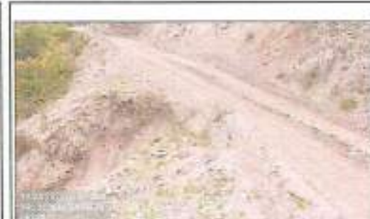
Foto 18: Punto de control - Perdida de plataforma Progresiva 67+500
