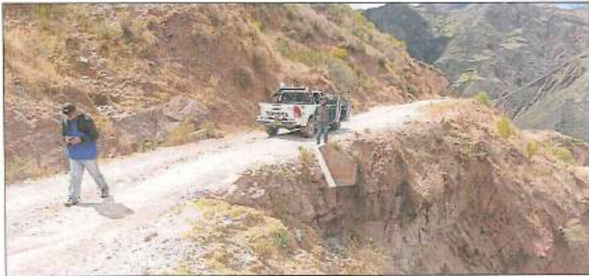
Imagen N°06: Alcantarilla parcialmente destruido 58+500
