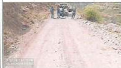
Foto 30: Daño en afirmado Progresiva 58+760
