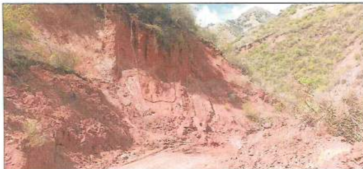
Imagen N°03: Daño en afirmado y derrumbe 55+440
