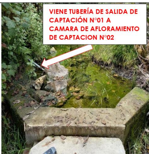
VISTA PANORÁMICA DE CÁMARA DE AFLORAMIENTO. SE OBSERVA LOSA DE TECHO DE AFLORAMIENTO TOTALMENTE COLAPSADA.
