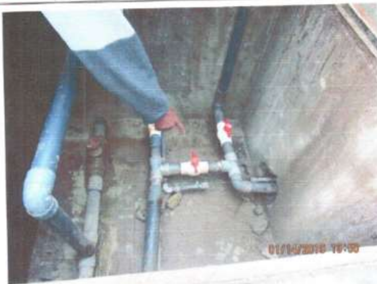
Estado de la estructura y caja de válvulas Reservorio 15 m 3 - El Hualte.
