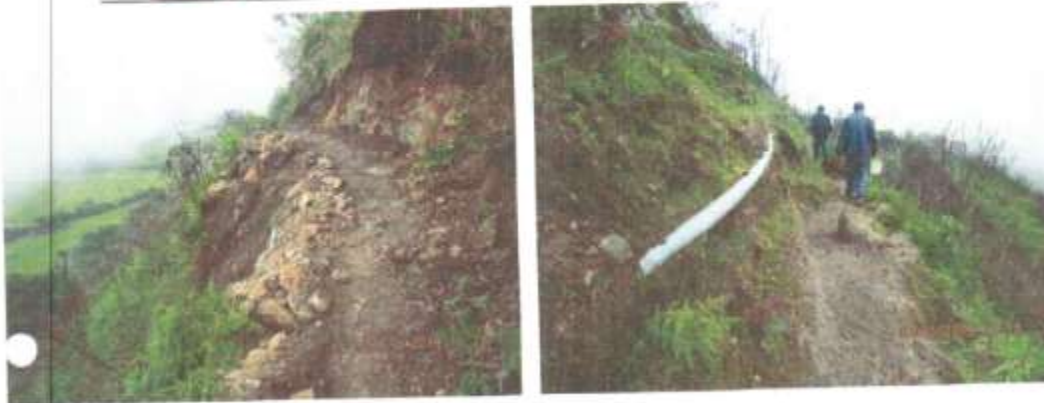
Estado de la Línea de Conducción y tubería expuesta El Hualte.
