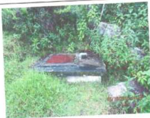
Cámara Rompe Presión Tipo 6 - Lc. Achiramayo
