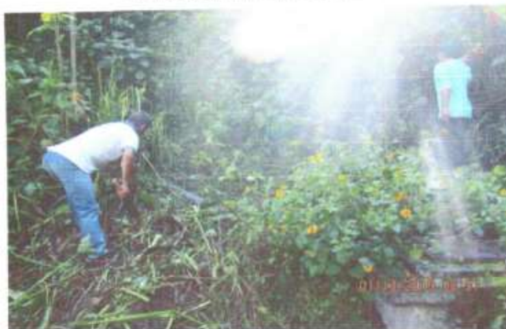
Imagen donde se aprecia que la vegetación ha invadido totalmente la captación, de esto se puede deducir el enraizamiento presente en las tuberías.
