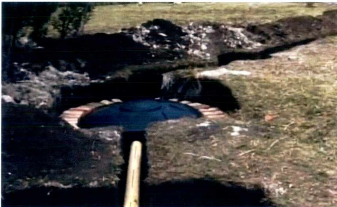
Vista de un tanque biodigestor autolimpiante
