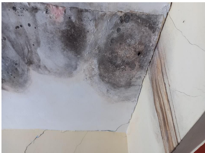
FOTO N°10 : CIELO RASO - PINTURA DE MUROS DETERIORADAS
