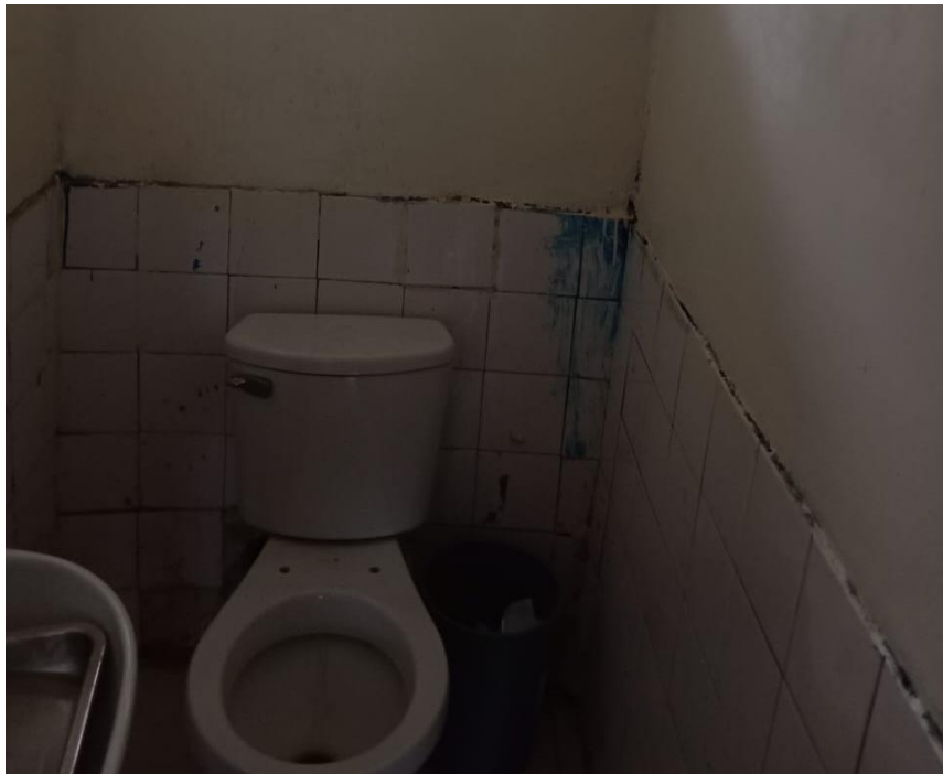
FOTO N°09 ACCESORIOS DE INODOROS MALOGRADOS
