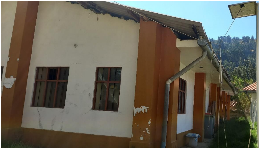
FOTO 02 : CANALETAS PLUVIALES DETERIORADAS
