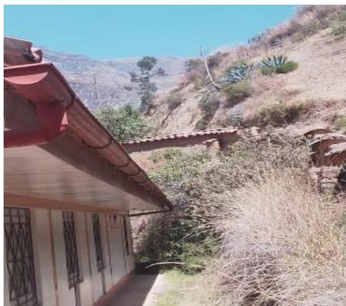
FOTO N°02: CANALETAS PLUVIALES
