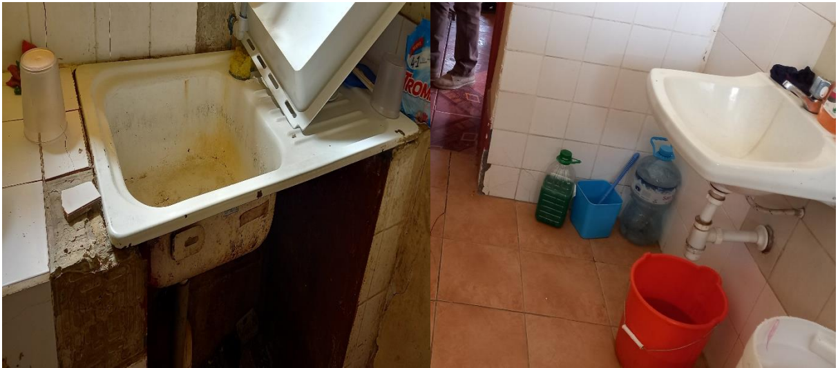
FOTO N°08: ACCESORIOS DE LAVADEROS MALOGRADOS
