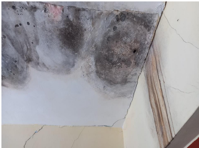
FOTO N°10 : CIELO RASO - PINTURA DE MUROS DETERIORADAS
