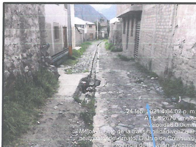
CANAL EN MAL ESTADO
