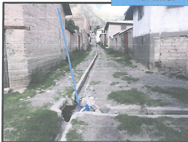
FALLA TOTAL DEL PAVIMENTO EMPEDRADO
