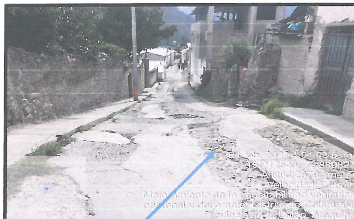
FALLA TOTAL DEL PAVIMENTO RIGIDO
