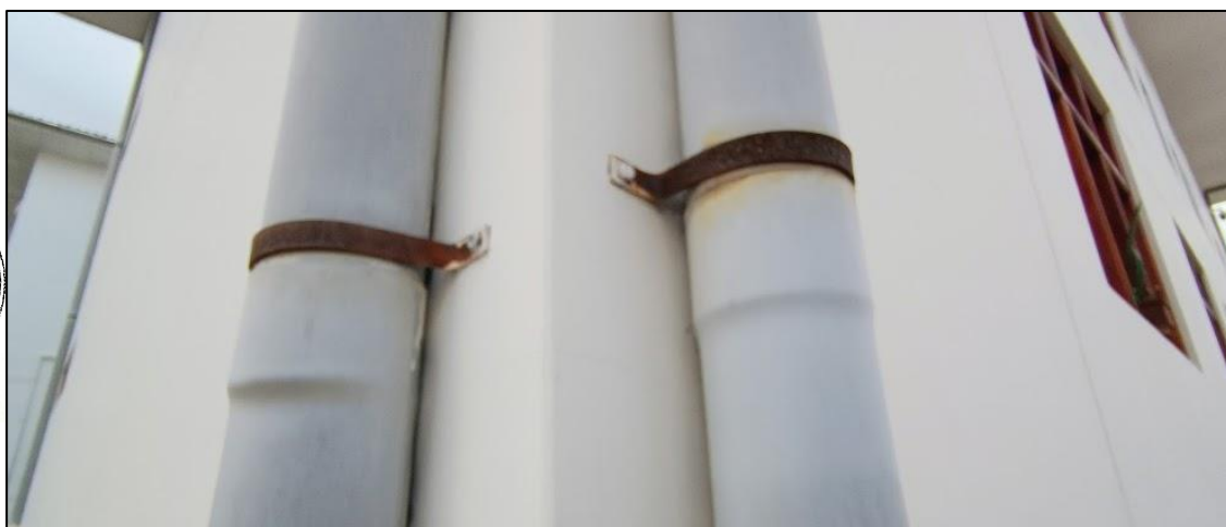
Imagen N°54: Vista de abrazaderas con presencia de óxido.
