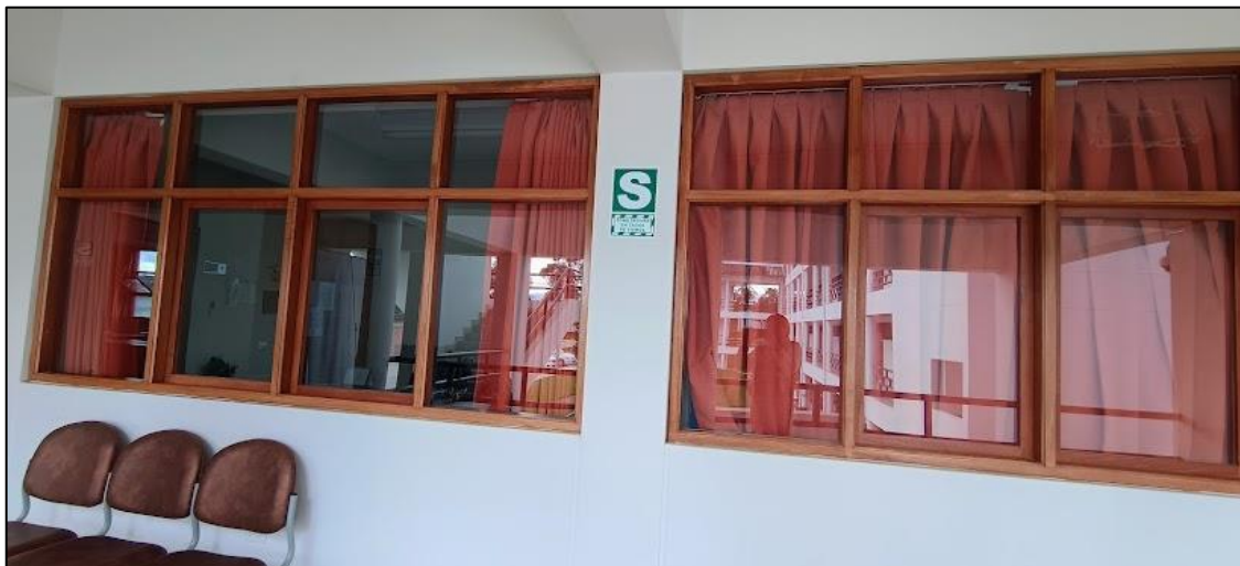
Imagen N°8: Vista de ventanas de marco de madera con decoloración por paso del tiempo en segundo nivel.
