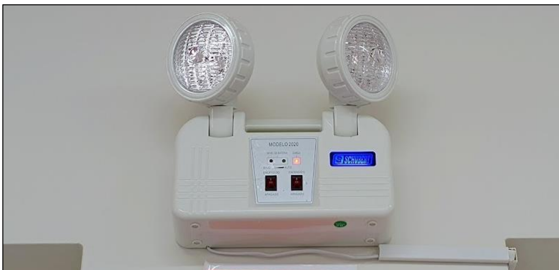
Imagen N°53: Las luces de emergencia se encuentran conectadas al circuito de tomacorrientes. Asimismo, la NTP IEC 60598-2-22 en su apartado 22.7.10, indica que no debe haber interruptores entre las lámparas y batería, de lo contrario se corre el riesgo de dejar las lámparas desconectadas y no encenderían durante una emergencia.
