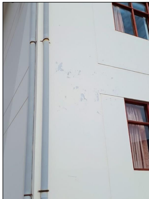
Imagen N°28: Vista de desprendimiento de pintura en zócalo de fachada oeste. Se aprecia también las abrazaderas de la bajada pluvial oxidadas.
