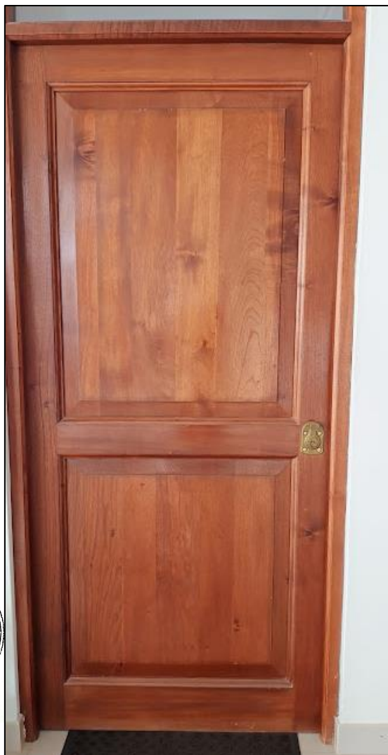
Imagen N°1: Vista de puerta en primer nivel con decoloración de acabado.
