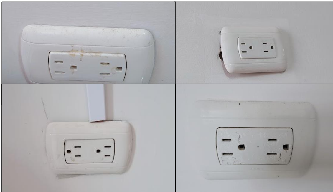
Imagen N°51: Vista de tomacorrientes desprendidos y en regular estado debido al uso. Tomacorrientes dúplex no normados según Código Nacional Eléctrico - Utilización (sección 150).
