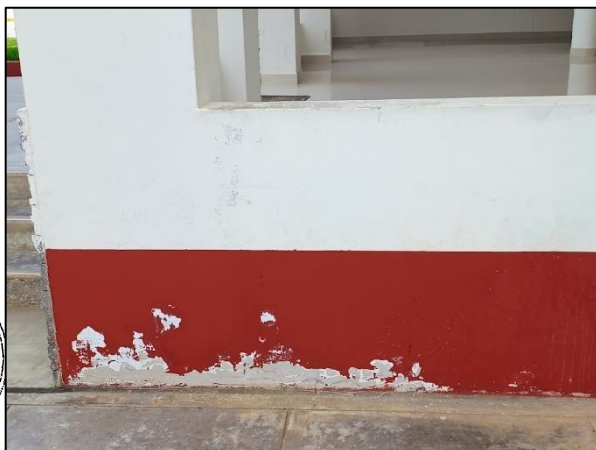
Imagen N°27: Vista de desprendimiento de pintura en zócalo de fachada sur.
