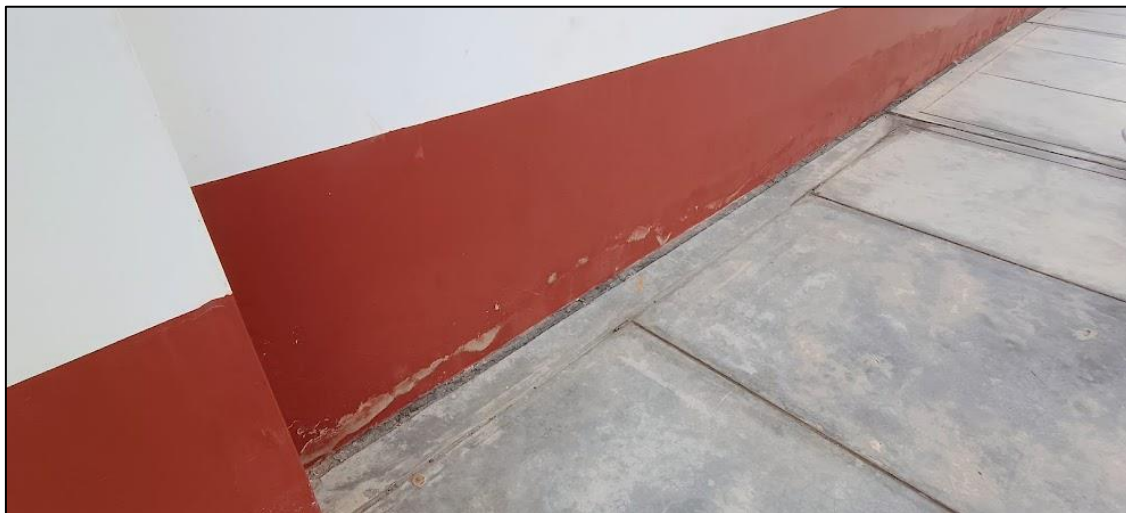
Imagen N°26: Vista de desprendimiento de pintura en zócalo de fachada este.
