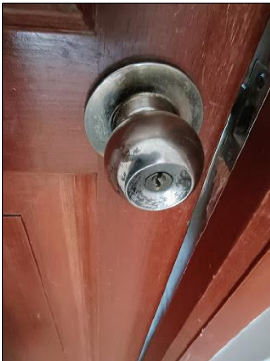
Imagen N°4: Vista de cerradura desgastada en baño.
