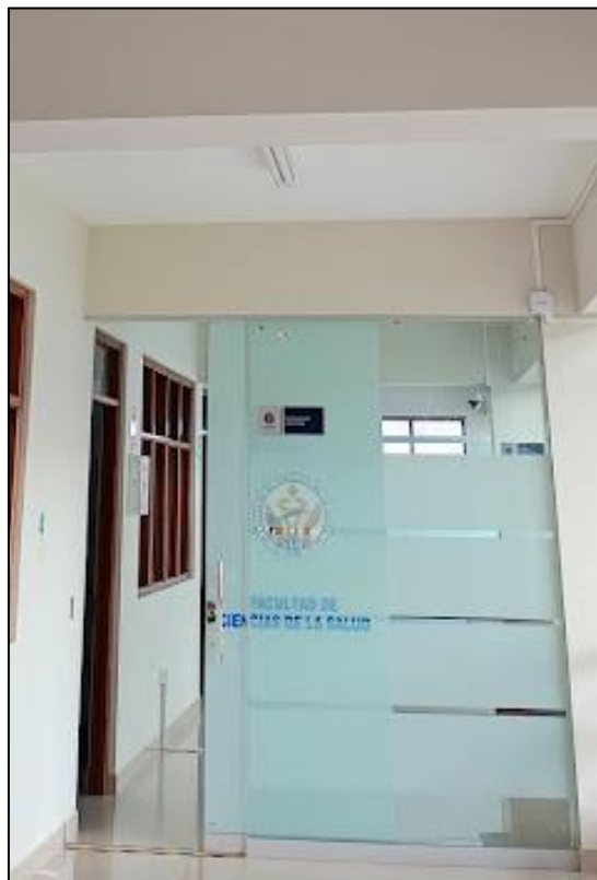
Imagen N°7: Vista de mampara de marco de aluminio y vidrio templado en buen estado en primer nivel.
