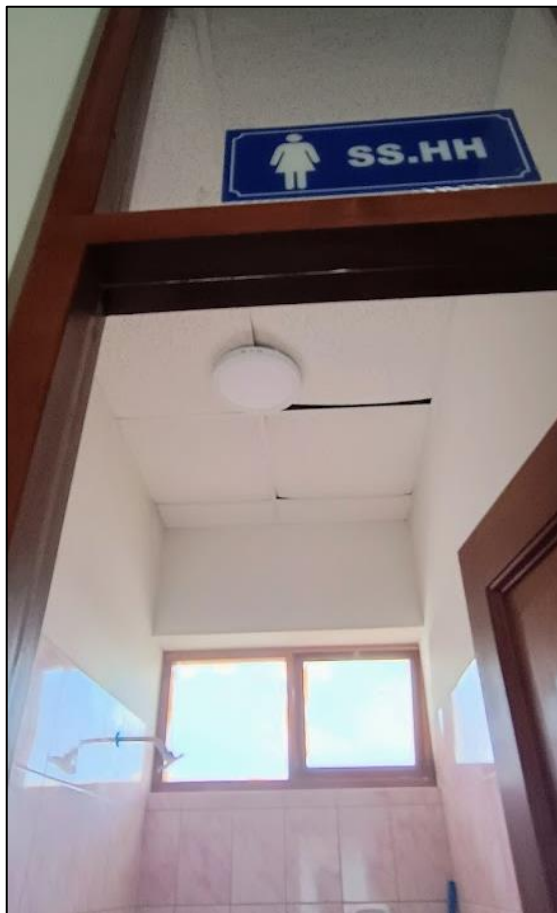
Imagen N°46: Vista de falso cielorraso de baldosas de fibra mineral en servicios higiénicos del tercer nivel. Se aprecia baldosas deformadas.
