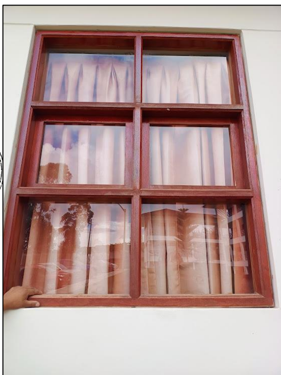
Imagen N°9: Vista de ventana fija y oscilante en fachada oeste, con marco de madera y vidrio crudo 3mm. Se aprecia la rugosidad del acabado, el cual no se adherido bien y no se encuentra uniforme.
