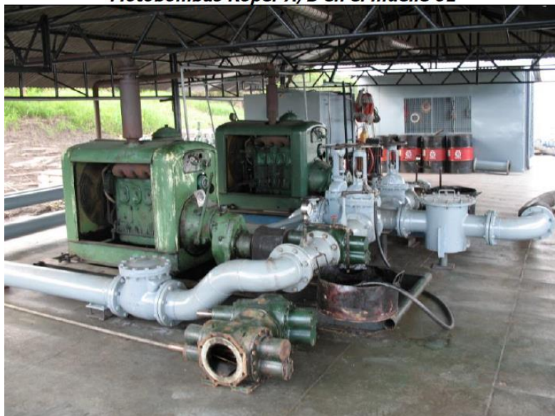
Motobombas Roper A/B en el muelle 01
