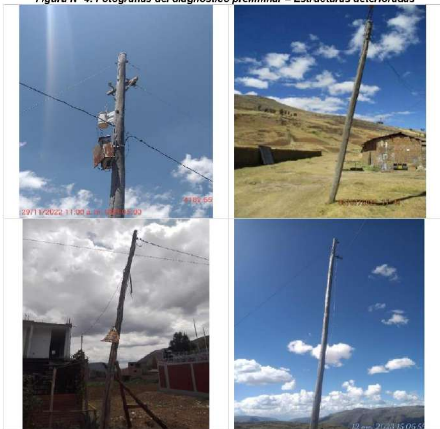
Figura N° 4: Fotografías del diagnóstico preliminar – Estructuras deterioradas
