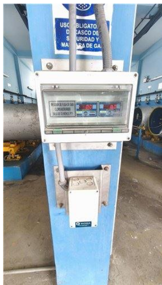
PTAP - Sistema Cloración sensor cloro
