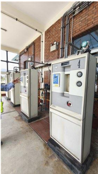
PTAP - Sistema Cloración - Scrubber
