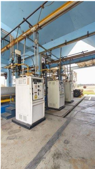
PTAP - Sistema Cloración - Scrubber
