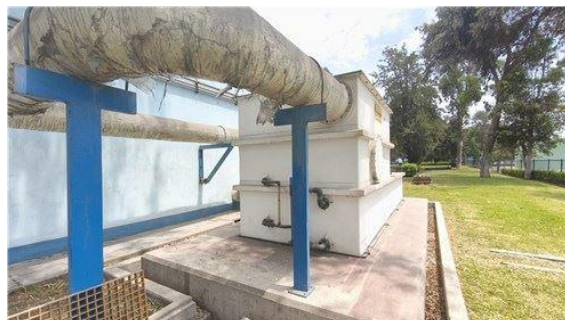
PTAP - Sistema Cloración - Scrubber
