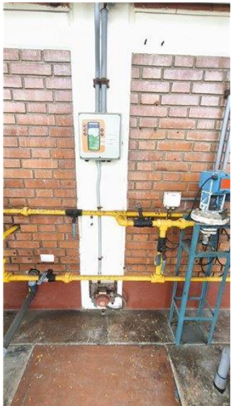
PTAP - Sistema Cloración - Scrubber
