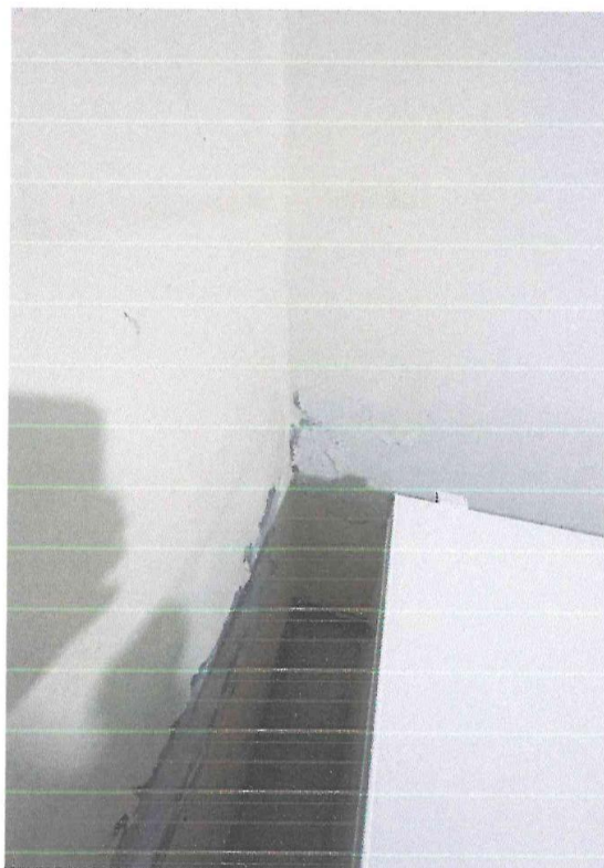
IMAGEN 04 – DESPRENDIMIENTO DE PINTURA EN MUROS.
