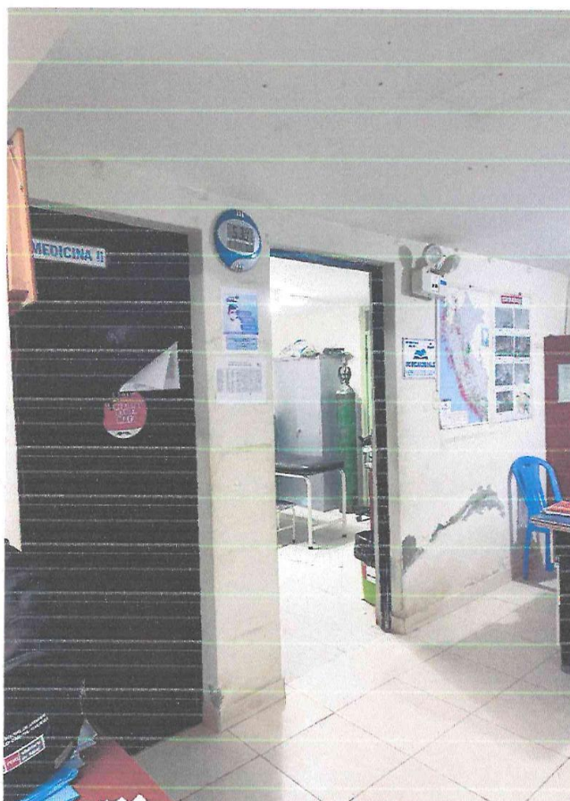
IMAGEN 06 – DESPRENDIMIENTO DE PINTURA EN MUROS Y TECHOS.
