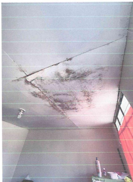
IMAGEN 16 – DETERIORO DE TECHO POR HUMEDAD.
