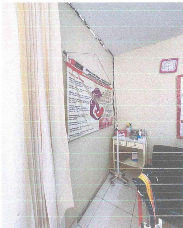
IMAGEN 08- JUNTA DE DILATACION EXPUESTA Y ABRIENDOSE.
