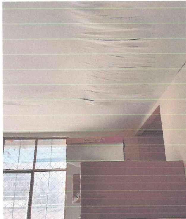
IMAGEN 17 – DETERIORO DE TECHO POR HUMEDAD.
