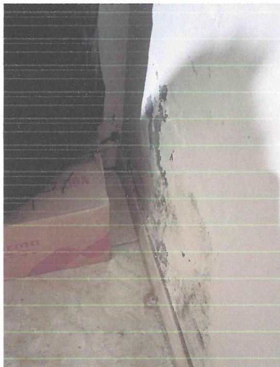
IMAGEN 18 – DESPRENDIMIENTO DE PINTURA EN MUROS.
