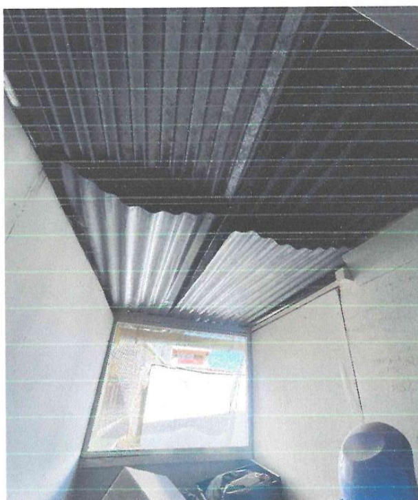
IMAGEN 08 – COBERTURA MAL INSTALADA.
