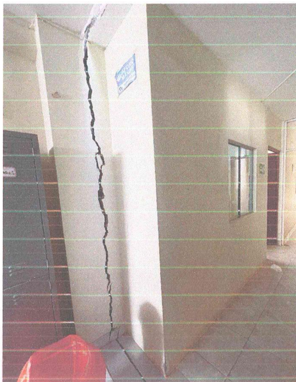
IMAGEN 05- JUNTA DE DILATACION EXPUESTA Y ABRIENDOSE.
