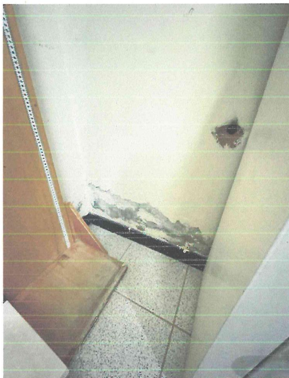
IMAGEN 22 – DESPRENDIMIENTO DE PINTURA EN MUROS.
