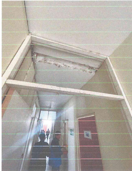
IMAGEN 03- JUNTAS DE DILATACION EXPUESTAS.
