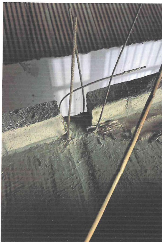
IMAGEN 05 – ESPACIO VACIO PARA TUBO DE BAJADA DE LLUVIA.
