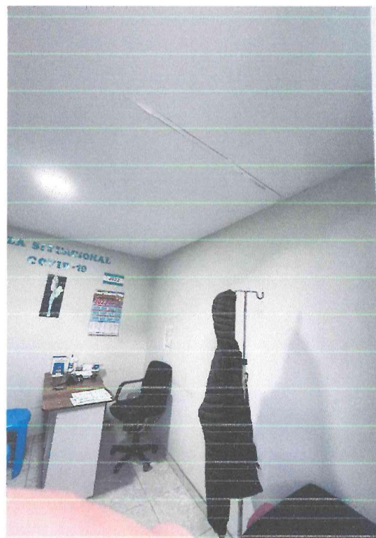
IMAGEN 10 – CIELO RASO DETERIORADO.
