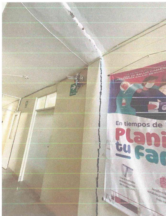
IMAGEN 04- JUNTA DE DILATACION EXPUESTA Y ABRIENDOSE.
