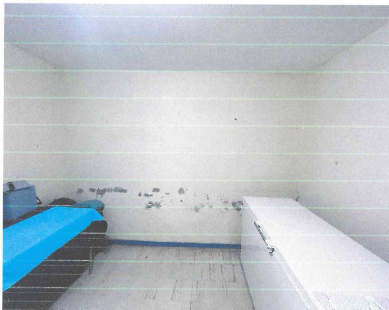
IMAGEN 05 – DESPRENDIMIENTO DE PINTURA EN MUROS.
