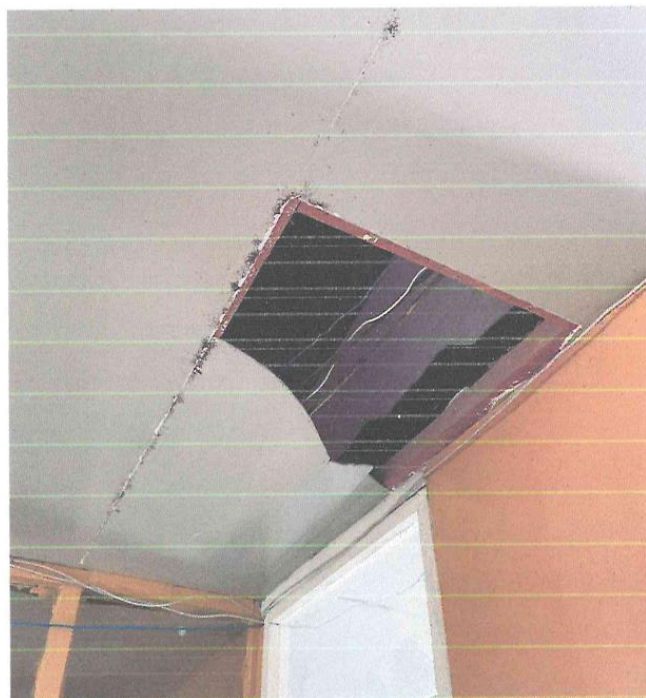
IMAGEN 18 – DETERIORO DE TECHO POR HUMEDAD.
