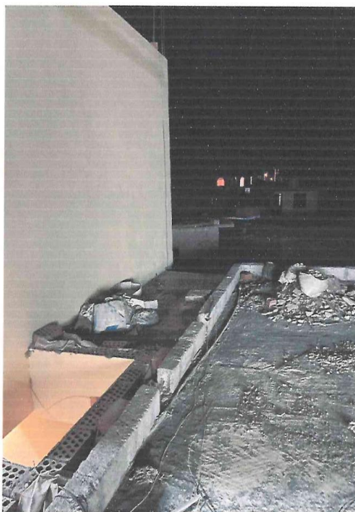
IMAGEN 02 – TECHO SIN BAJADA DE LLUVIAS.
