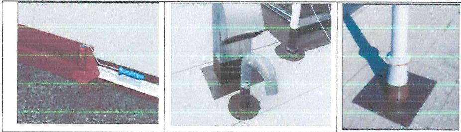
Ejemplos de remates en zona de equipos
