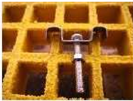
Clips de fijación tipo M, en acero INOX 304, con perno de \frac{1}{4} x 2", tuerca y arandela. Se requieren 4 unidades por m2 de grating.
