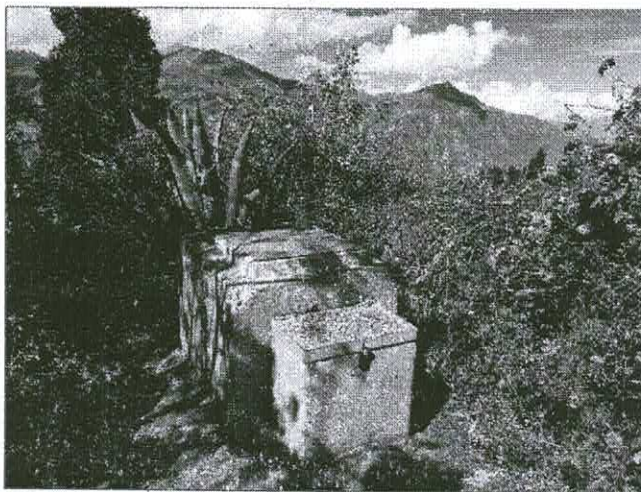
Foto N°3. Cámaras rompe presión en mal estado con tapas oxidadas y paredes erosionadas por el tiempo. Urge su mejoramiento.
