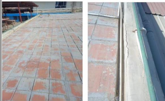
FOTO N° 07 Y 08: Se observa en la losa aligerada el ladrillo pastelero en mal estado sin impermeabilizar y deteriorado; Parapetos de concreto en mal estado..
