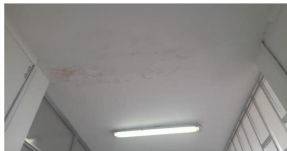
FOTO N°03: Vista interior del área donde se proyectará la cobertura el cual encontramos filtraciones, cieloraso en mal estado
