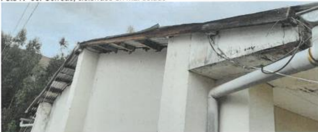
Foto N° 06: Correas, cielorraso en mal estado
