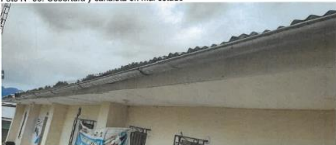
Foto N° 06: Cobertura y canaleta en mal estado
