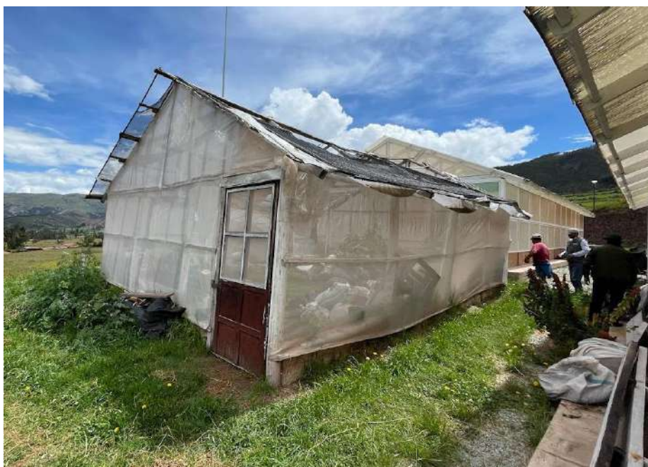
Imagen N°02: Fotografía exterior - situación actual de la cámara fría en el anexo Zurite. Se aprecia que la cámara fría se encuentra en estado deteriorado, tanto la malla perimetral, y la cobertura.
