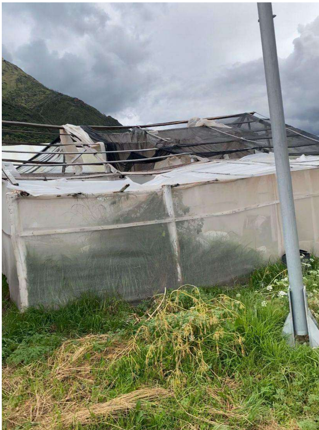
Imagen N°01: Fotografía exterior - situación actual de la cámara fría en el anexo Zurite. Se aprecia que la cámara fría se encuentra en estado deteriorado, tanto la malla perimetral, y la cobertura.
