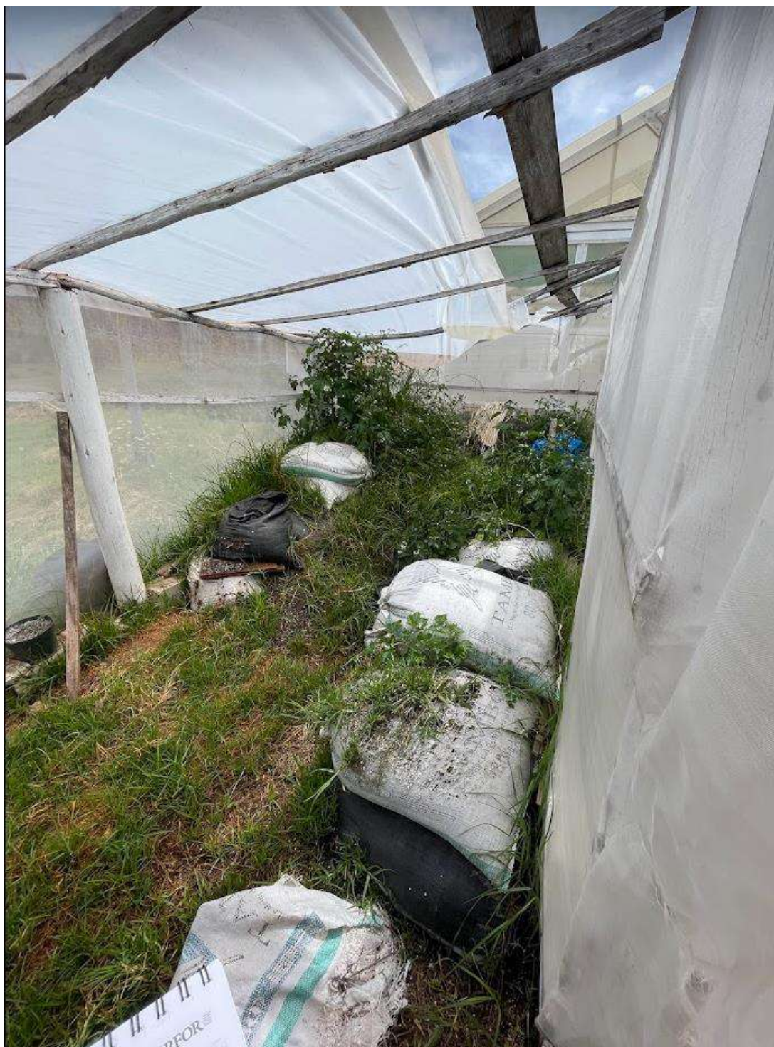
Imagen N°03: Fotografía interior - situación actual de la cámara fría en el anexo Zurite. Se aprecia que la cámara fría se encuentra en estado deteriorado, no existe piso adecuado, estructura, ni cerramientos adecuados.
