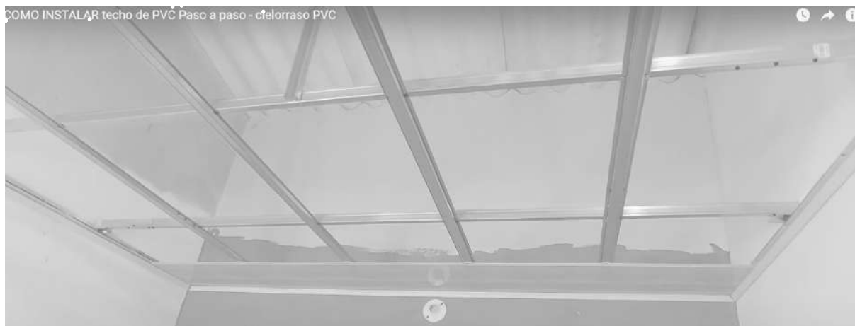
Imagen 20. Imagen de instalación, una vez instalado la trama estructural, se procede a instalar los paneles de PVC, de 25 de ancho por 5.80 metros de largo.
