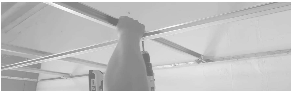
imagen 19. Imagen de instalación de los ángulos perimetrales y omegas, para formar la trama estructural que soportará a las baldosas de pvc.
