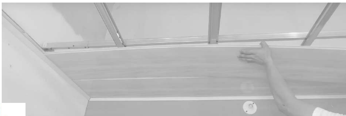
Imagen 21. Imagen de unión de baldosas de PVC tipo machihembradas.
