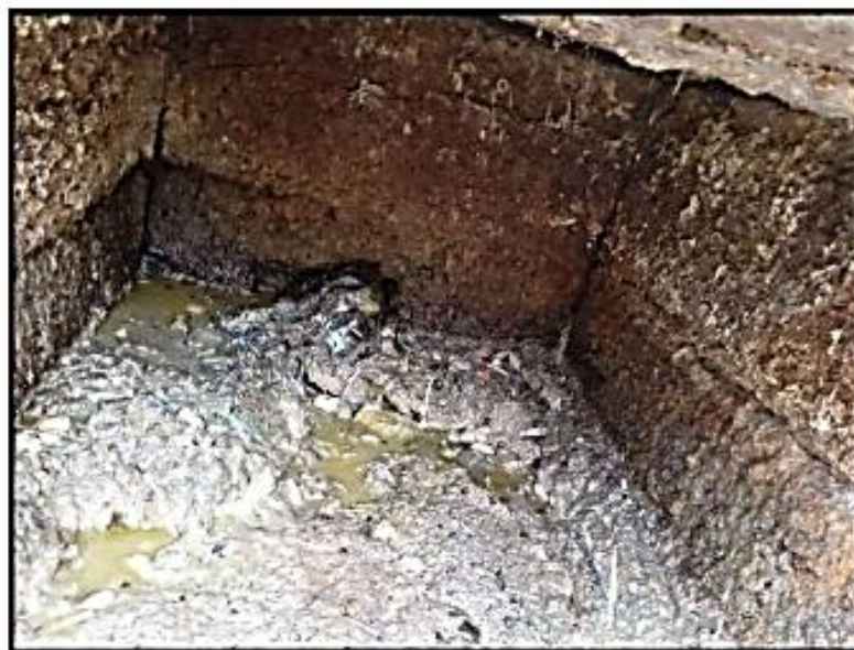
Imagen N° 10: Podemos apreciar una trampa de grasas que no está trabajando y además que las paredes de concreto están totalmente en pésimas condiciones, se plantea demoler y construir una nueva.
