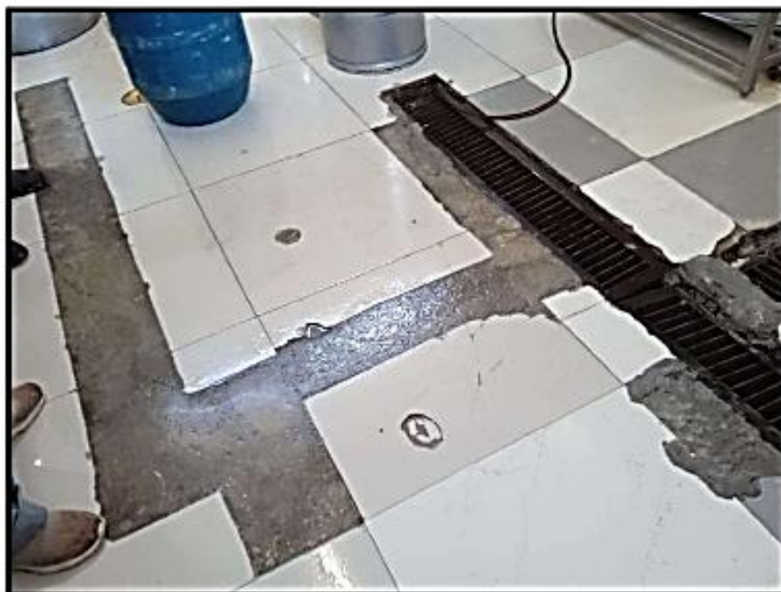
Imagen N° 12: Podemos apreciar que necesita cambio de porcelanato y mantenimiento de las rejillas.
