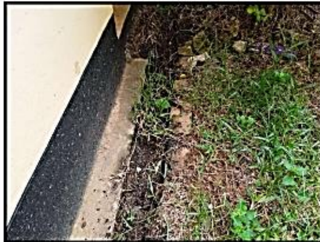
Imagen N° 9: Podemos apreciar presencia de vegetación y la cuneta colmatada, se plantea limpieza de ésta.
