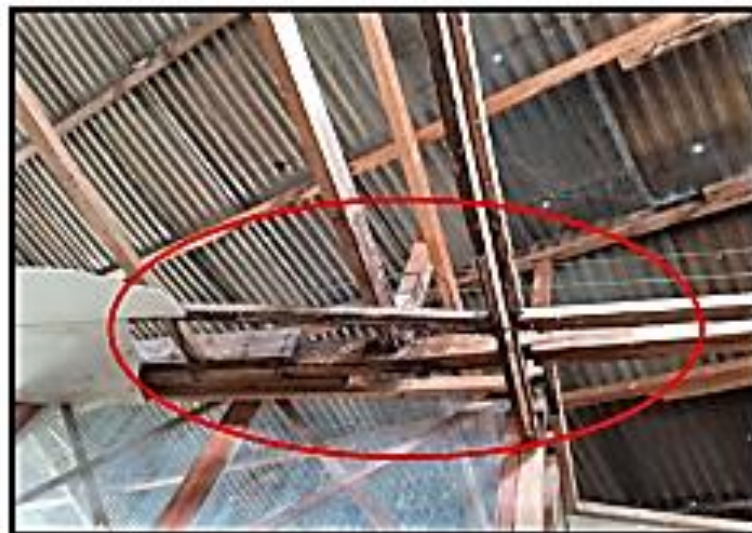
Imagen N° 2: Se observa que las vigas del ferral están en mal estado por lo tanto se plantea
