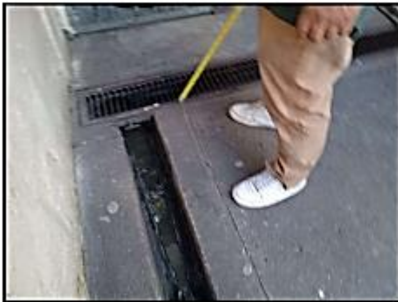
Imagen N° 6: Podemos apreciar cunetas existentes de medidas insuficientes, se plantea ampliar para cumplir con la demanda de caudal.
