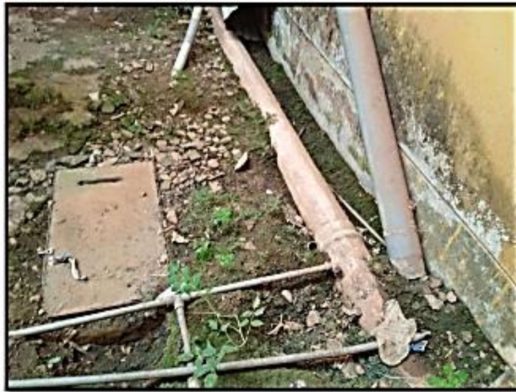
Imagen N° 11: Se plantea acondicionar una caja registro con rejilla en el tubo de 8" para evitar inundaciones
