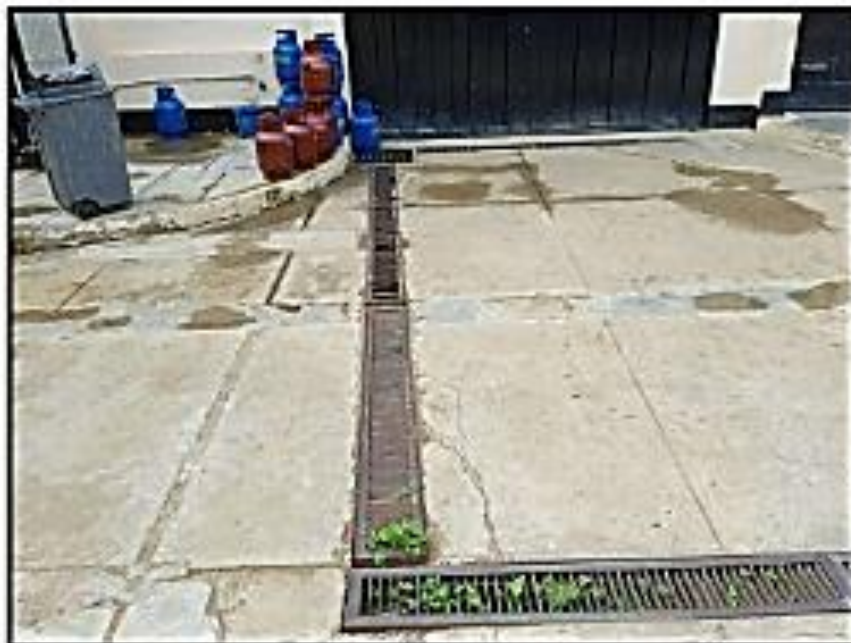
Imagen N° 4: Cunetas existentes a demoler ya que la sección que presentan es insuficiente.
