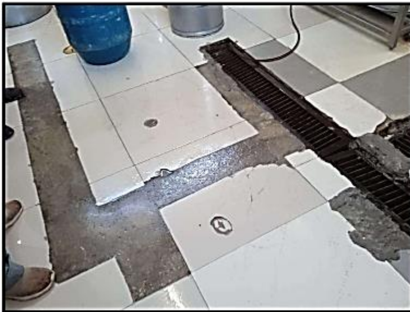
Imagen N° 12: Podemos apreciar que necesita cambio de porcelanato y mantenimiento de las rejillas.
