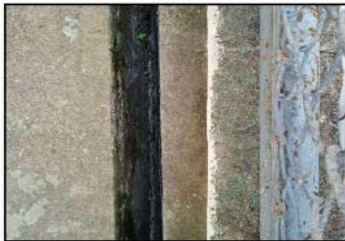
Imagen N° 16: Se plantea demolición de la cuneta existente ya que presenta medidas insuficientes para el caudal de diseño.
