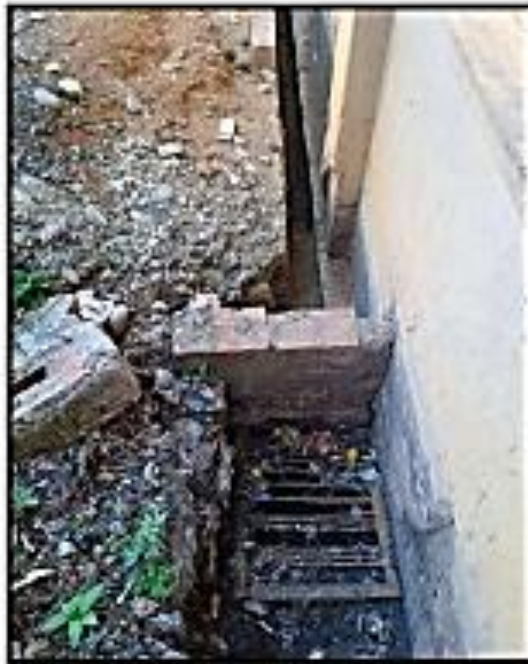
Imagen N° 5: Podemos apreciar una rejilla y caja receptora de agua en muy mal estado
