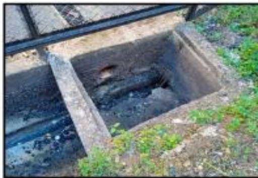
Imagen N° 15: Se plantea demolición de la caja ya que no cumple con las características necesarias, además también se demolerá la cuneta existente.
