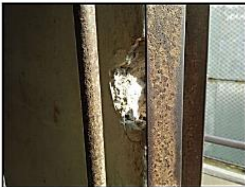
Imagen N° 14: Se plantea resane de los muros y cambio de bisagras.
