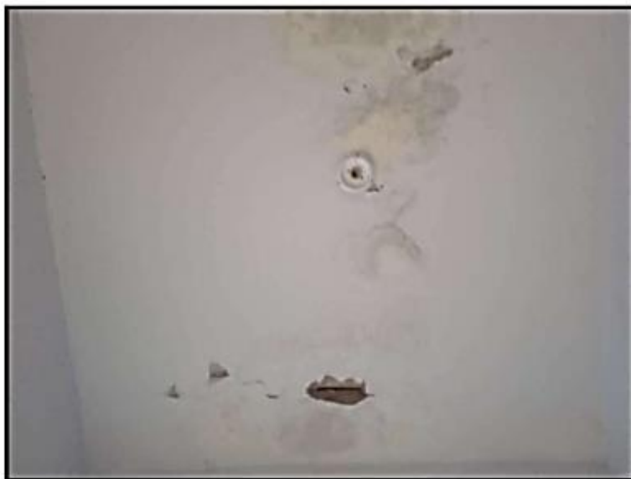
Imagen N° 8: Podemos apreciar que existen filtraciones por ello se plantea cubrir el techo con una cobertura de calamina.
