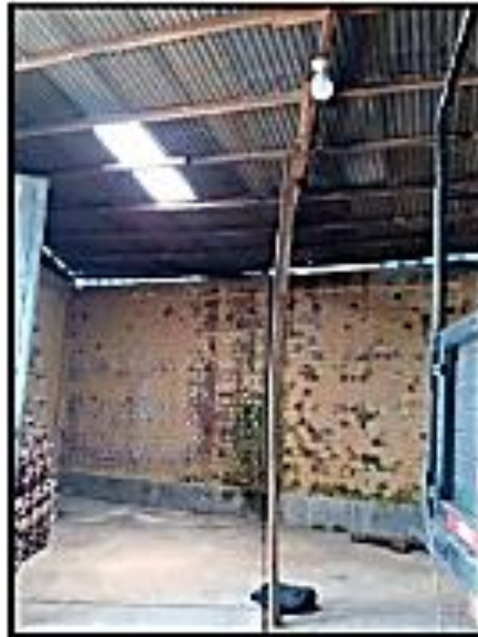
Imagen N° 1: Se observa que el parante de madera es insuficiente para soportar la carga que transmite el techo por tanto se plantea cambiar el soporte por uno de mejores características y medidas.
