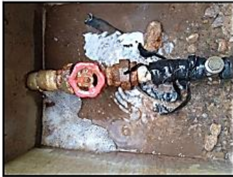
Imagen N° 3: Podemos visualizar que la válvula compuerta, check y sus accesorios ya no están cumpliendo su función y se presenta fuga de agua por lo tanto se plantea reemplazo total.
