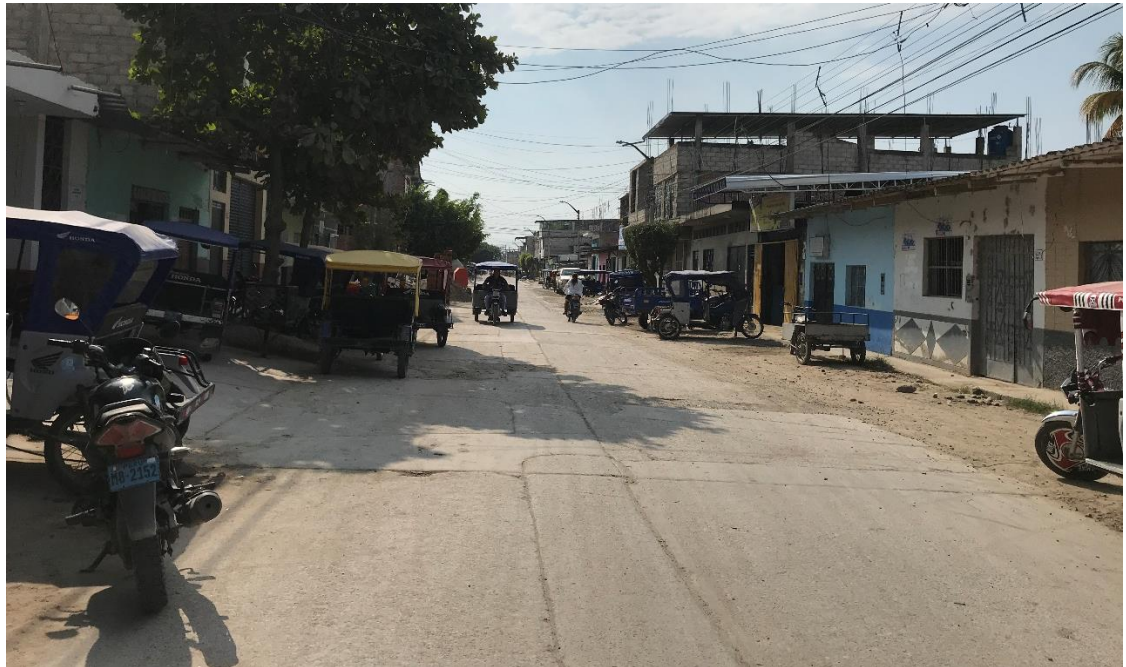
Ilustración 57: Progresiva: 0+090 JR. SARGENTO LORES – Cuadra 06 Calle con pavimento existente (entre el Jr. Verdad y Jr. Cajamarca) en mal estado. Viviendas de hasta 2 pisos, cuentan con veredas irregulares deterioradas a ambos lados de la vía. Árboles existentes en ambos lados de la vía.
