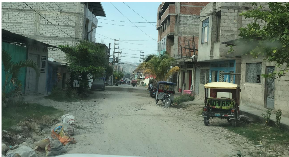
Ilustración 29: Progresiva: 0+010 JR. LA VERDAD – Cuadra 08 Calle sin pavimentar desde Jr. Miraflores hasta Jr. Sargento Lores. Viviendas de hasta tres pisos, cuentan con veredas irregulares deterioradas en ambos lados de la vía.
