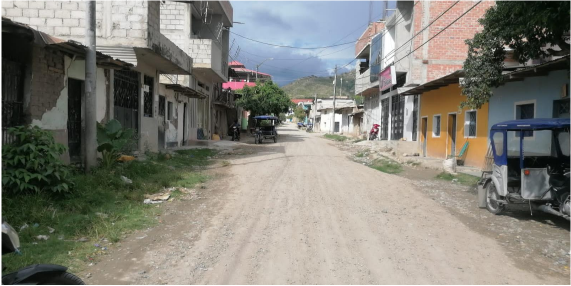
Ilustración 96: Progresiva: 0+055 JR. HUASCARAN – Cuadra 05 Calle en terreno natural (entre la Av. Circunvalación hasta Jr. La Libertad). Viviendas hasta de 3 pisos. Se visualiza arboles existentes. Presenta un relieve uniforme en la vía, viviendas de un solo nivel.
