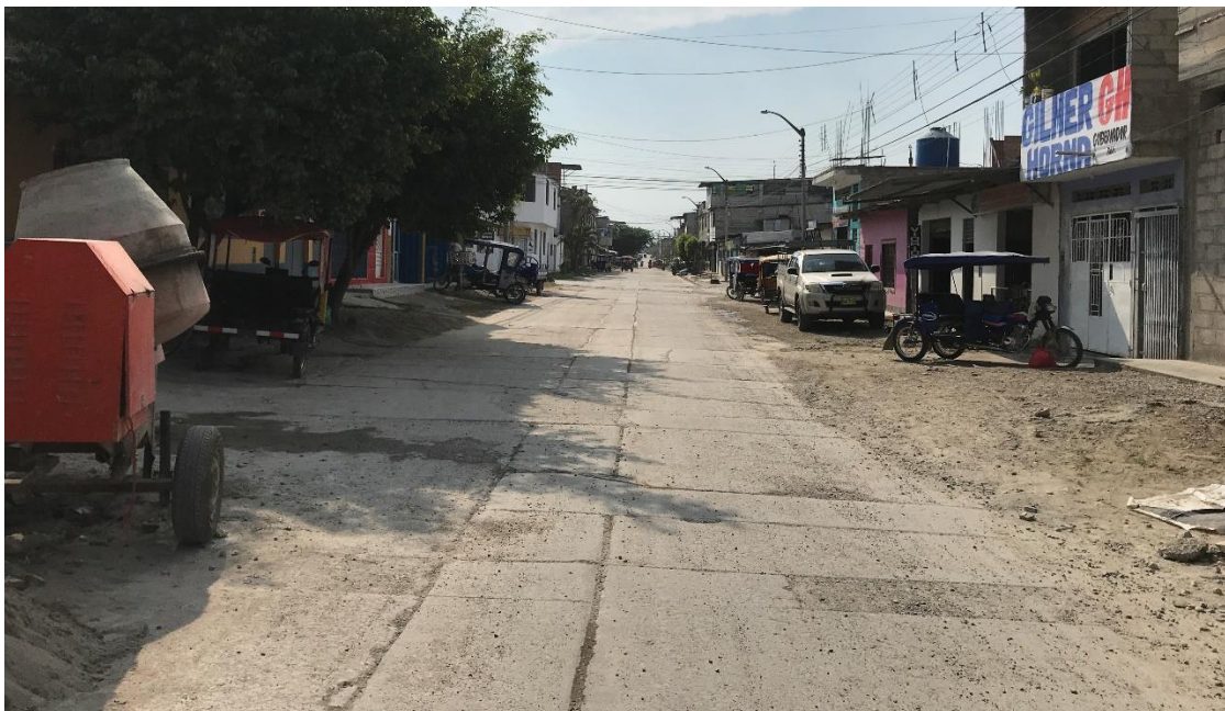
Ilustración 58: Progresiva: 0+045 JR. SARGENTO LORES – Cuadra 06 Calle con pavimento existente (entre el Jr. Verdad y Jr. Cajamarca) en mal estado. Viviendas de hasta 2 pisos, cuentan con veredas irregulares deterioradas a ambos lados de la vía. Árboles existentes a un solo lado de la vía.
