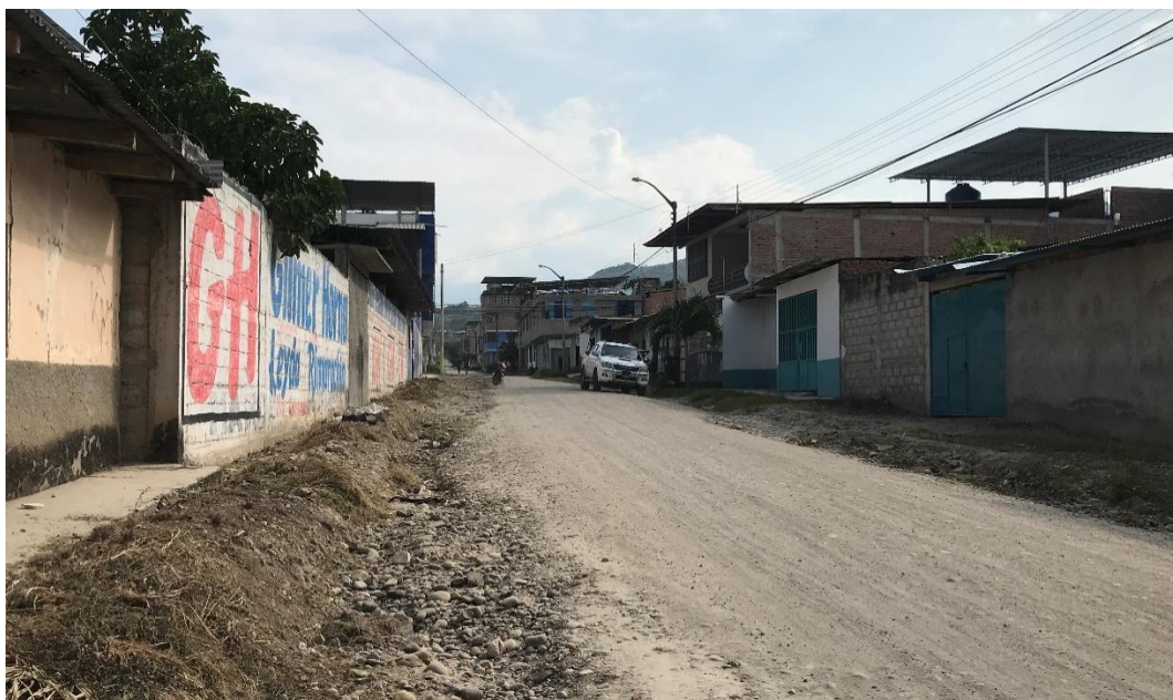
Ilustración 10: Progresiva: 0+075 JR. HUANDOY – Cuadra 04 Calle con afirmado (entre la Jr. Sargento Lores y Jr. Los Cedros). Las viviendas de un solo piso, cuentan con veredas irregulares a ambos lados de la vía.
