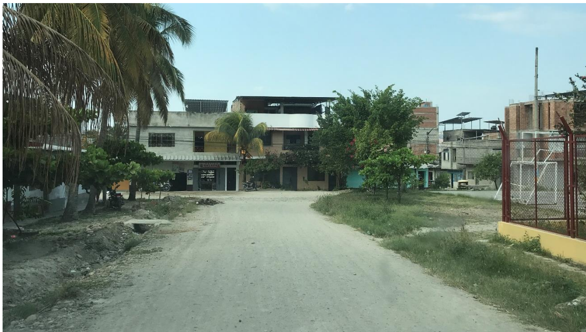
Ilustración 28: Progresiva: 0+030 JR. LA VERDAD – Cuadra 09 Calle en terreno natural sin pavimentar, (desde Jr. Miraflores hasta Jr. La Libertad), presenta una ligera pendiente en un lado de la vía, viviendas de uno y dos niveles con veredas irregulares.
