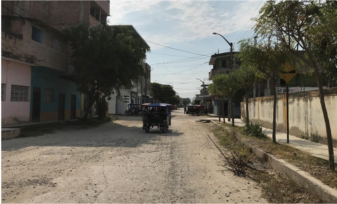
Ilustración 56: Progresiva: 0+025 JR. SARGENTO LORES – Cuadra 05 Calle con pavimento existente (entre el Jr. Verdad y Jr. Piura) en mal estado. Viviendas de hasta 4 pisos, cuentan con veredas irregulares deterioradas a ambos lados de la vía. Árboles existentes en ambos lados de la vía.
