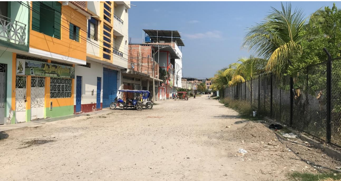
Ilustración 75: Progresiva: 0+005 JR. MIRAFLORES – Cuadra 03 Calle en terreno natural (entre el Jr. Huandoy y Jr. Cajamarca). Viviendas de hasta 5 pisos, cuentan con veredas irregulares deterioradas a un lado de la vía.
