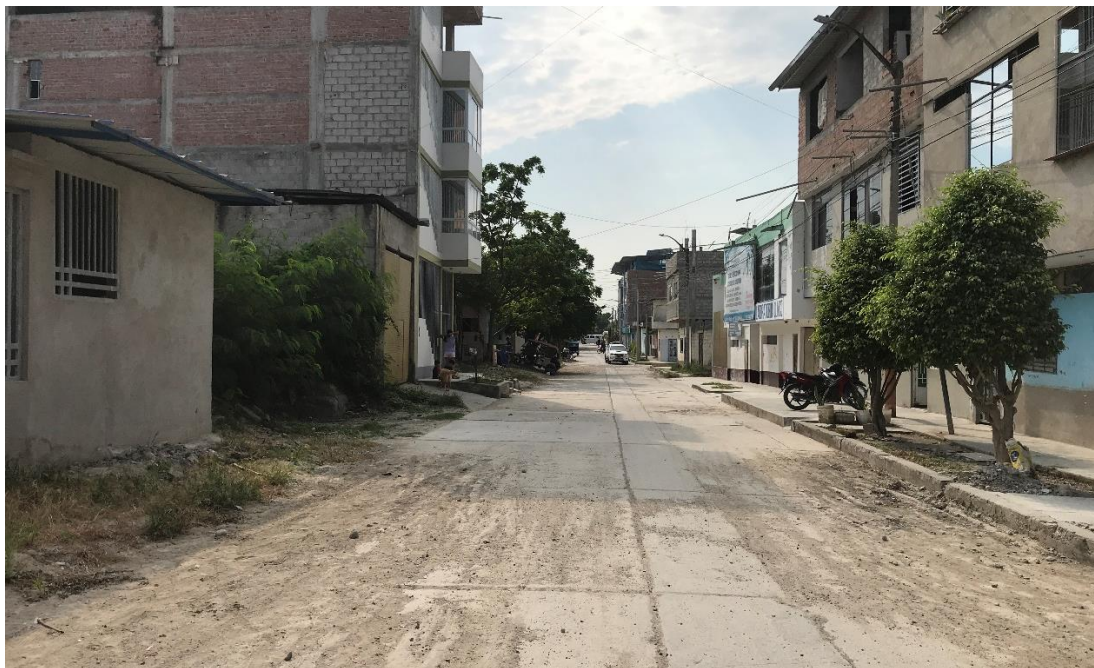
Ilustración 50: Progresiva: 0+069 JR. LOS CEDROS – Cuadra 05 Calle con pavimento existente (entre el Jr. Huandoy y Jr. Huascarán) en mal estado. Viviendas de uno y dos pisos, cuentan con veredas irregulares deterioradas a ambos lados de la vía. Árboles existentes en ambos lados de la vía.
