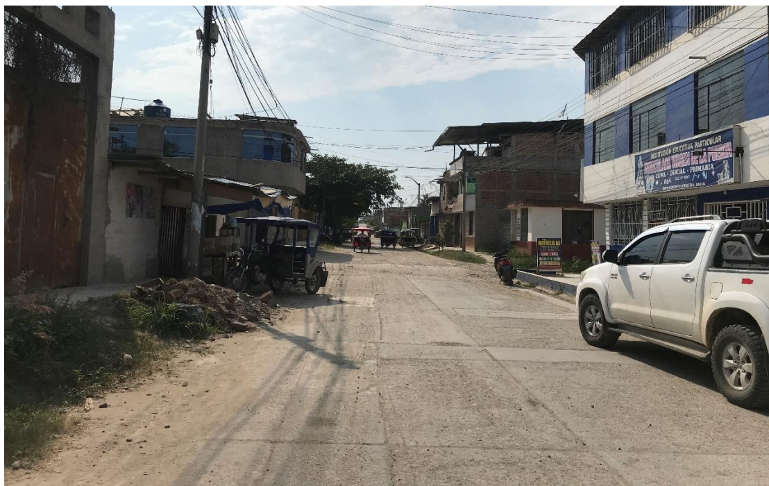
Ilustración 62: Progresiva: 0+015 JR. SARGENTO LORES – Cuadra 07 Calle con pavimento existente (entre el Jr. Huandoy y Jr. Cajamarca) en mal estado. Viviendas de hasta 3 pisos, cuentan con veredas irregulares deterioradas a ambos lados de la vía.
