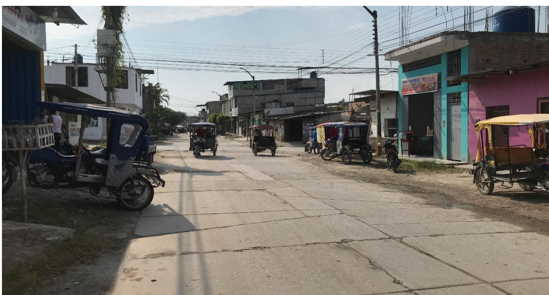
Ilustración 59: Progresiva: 0+010 JR. SARGENTO LORES – Cuadra 06 Calle con pavimento existente (entre el Jr. Verdad y Jr. Cajamarca) en mal estado. Viviendas de hasta 2 pisos, cuentan con veredas irregulares deterioradas a ambos lados de la vía.
