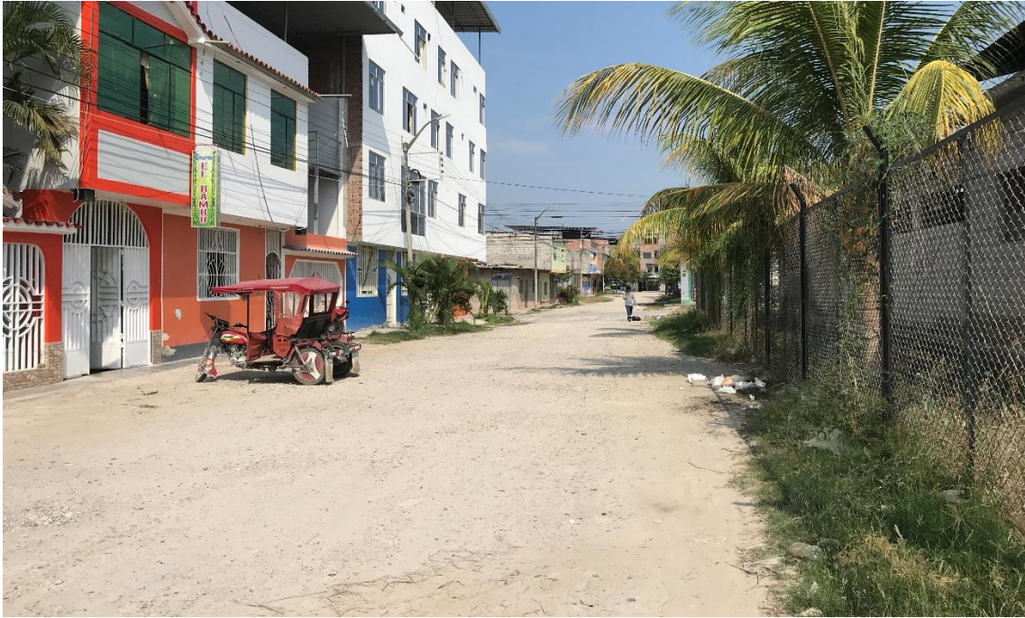
Ilustración 76: Progresiva: 0+045 JR. MIRAFLORES – Cuadra 03 Calle en terreno natural (entre el Jr. Huandoy y Jr. Cajamarca). Viviendas de hasta 5 pisos, cuentan con veredas irregulares deterioradas a un lado de la vía.
