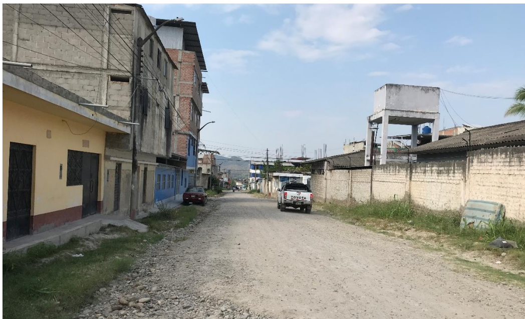
Ilustración 03: Progresiva: 0+090 JR. HUANDOY – Cuadra 06 Calle en terreno con afirmado con un relieve uniforme, casas de hasta cinco niveles y veredas existentes en un solo lado de la vía.
