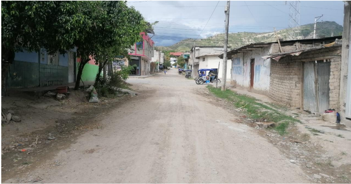
Ilustración 97: Progresiva: 0+025 JR. HUASCARAN – Cuadra 05 Calle en terreno natural (entre la Av. Circunvalación hasta Jr. La Libertad). Viviendas hasta de 2 pisos. Se visualiza arboles existentes. Presenta un relieve uniforme en la vía, viviendas de un solo nivel.
