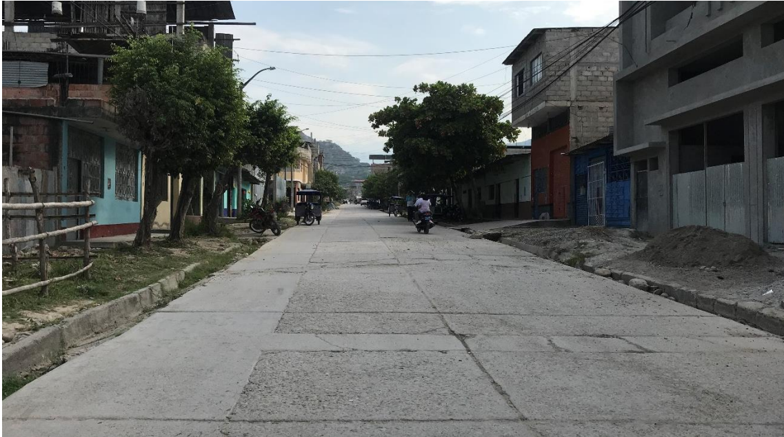
Ilustración 14: Progresiva: 0+155 JR. CAJAMARCA – Cuadra 05 Calle con pavimento existentes (entre el Jr. Los Cedros y Av. Héroes del Cenepa) en mal estado. Viviendas de uno y dos pisos, cuentan con veredas irregulares deterioradas en ambos lados de la vía. Presenta arboles existentes en ambos lados de la vía.
