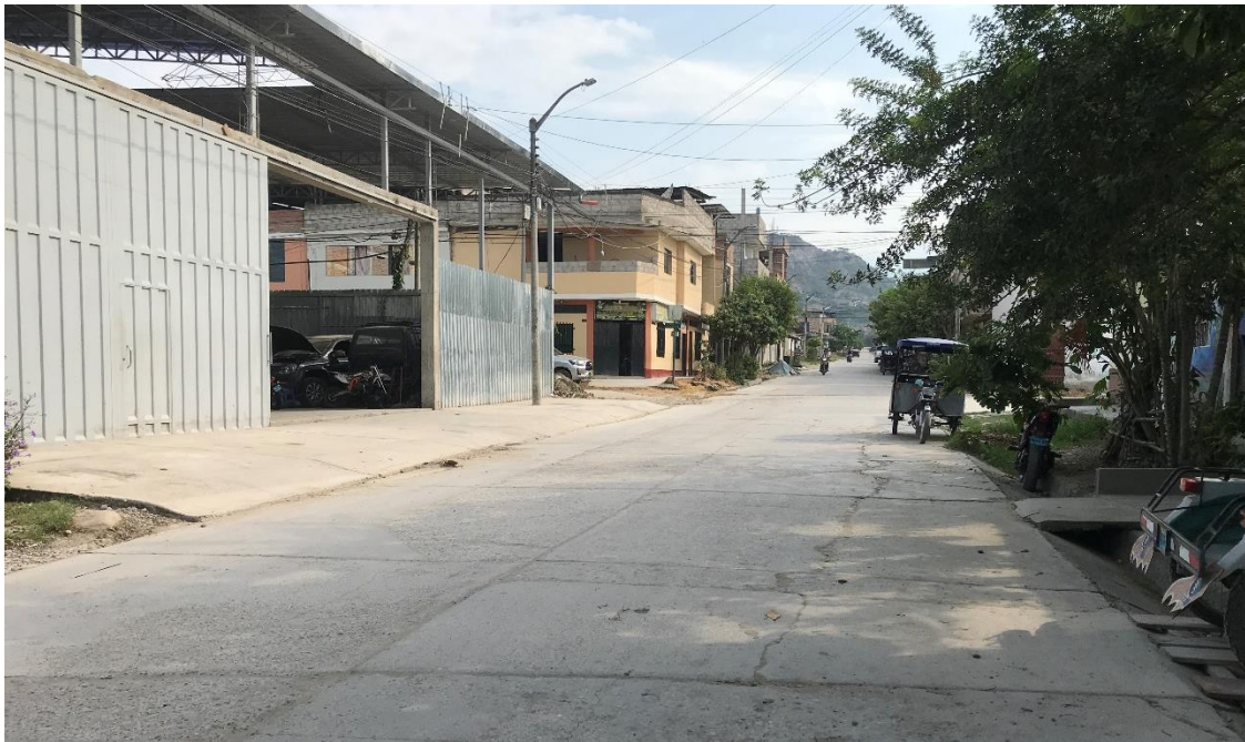
Ilustración 15: Progresiva: 0+105 JR. CAJAMARCA – Cuadra 05 Calle con pavimento existente (entre el Jr. Los Cedros y Av. Héroes del Cenepa) en mal estado. Viviendas de uno y dos pisos, cuentan con veredas irregulares deterioradas en ambos lados de la vía.
