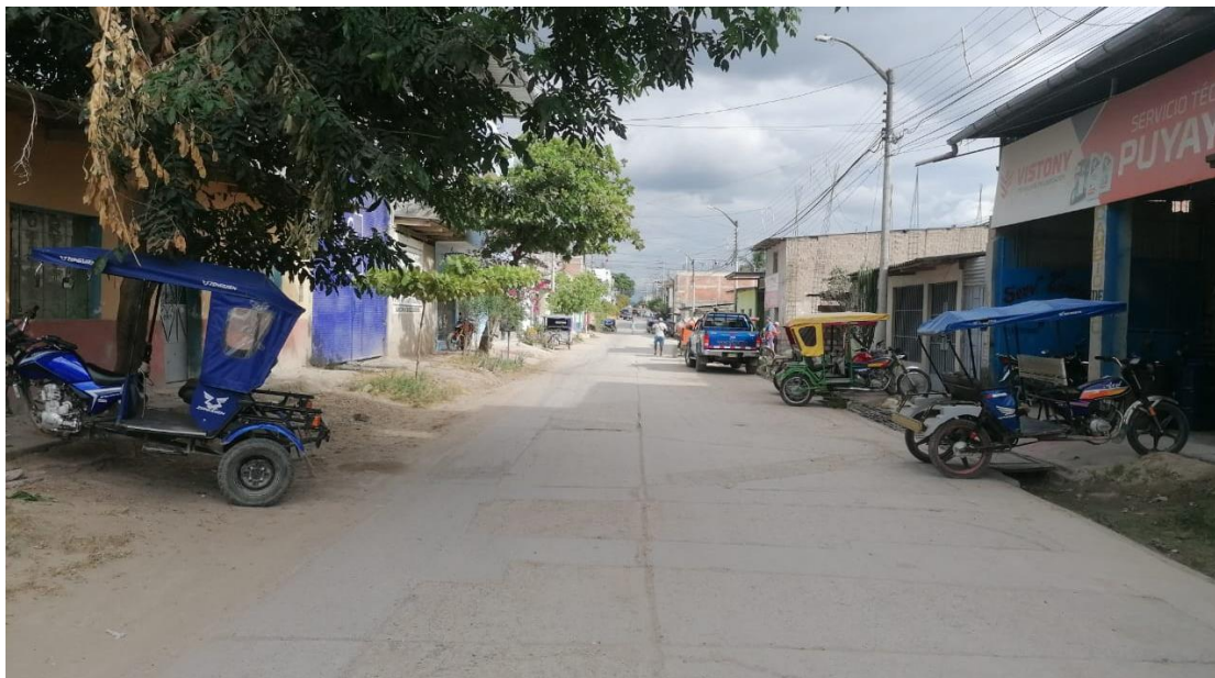
Ilustración 64: Progresiva: 0+050 JR. SARGENTO LORES – Cuadra 08 Calle con pavimento existente (entre el Jr. Huandoy y Jr. Huascarán) en mal estado. Viviendas de hasta 2 pisos, cuentan con veredas irregulares deterioradas a ambos lados de la vía. Árboles existentes a un lado de la vía.
