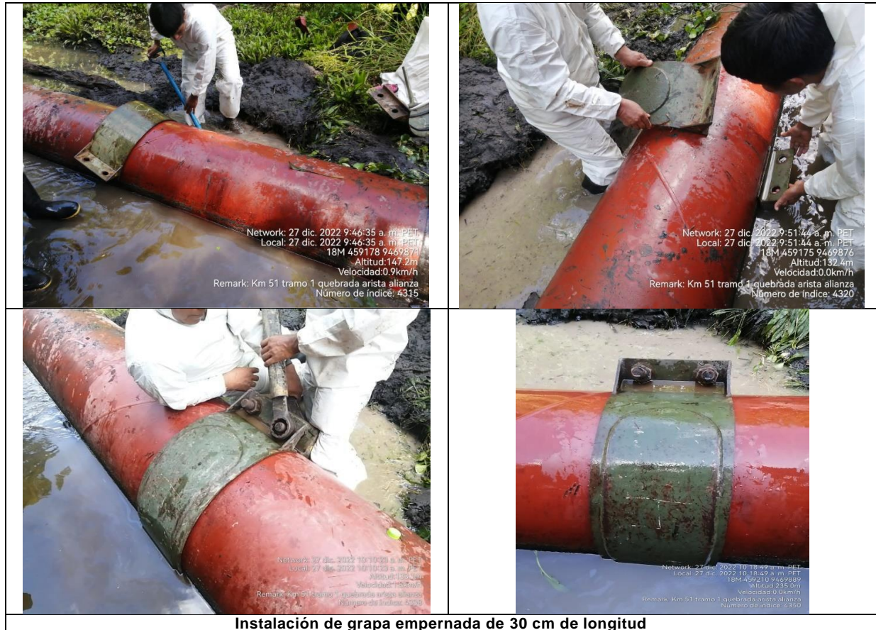
Instalación de grapa empernada de 30 cm de longitud
