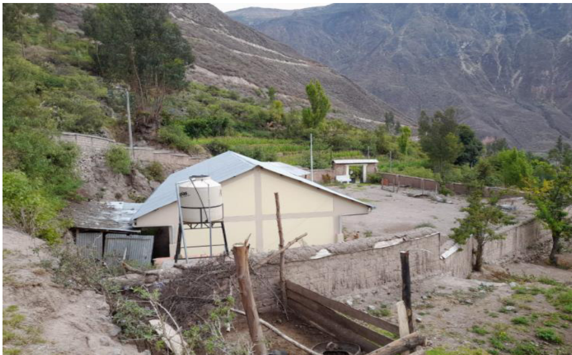
Fotografía: Se muestra cerco perimétrico de abobe, incompleto y en estado de regular a malo de la IE N° 40541 SANTA ROSA DE LIMA
