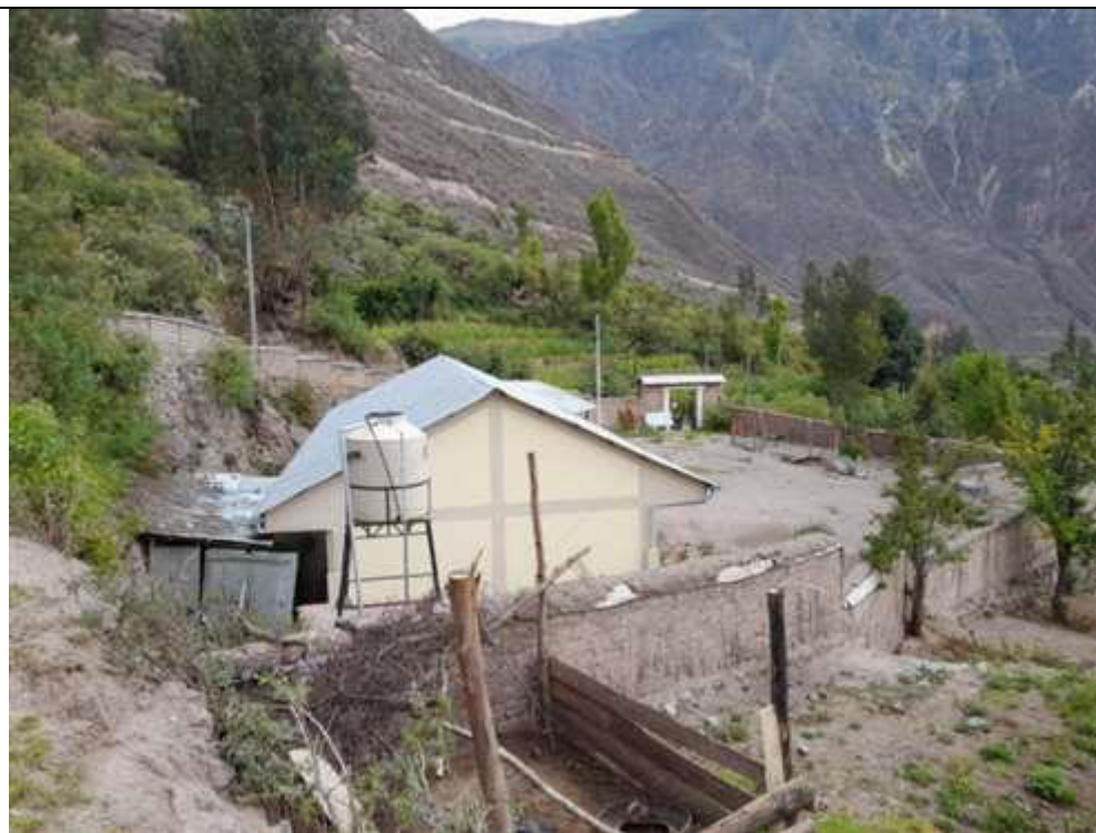
Fotografía N°02: Se muestra cerco perimétrico de adobe, incompleto y en estado de regular a malo de la IE N° 40541 SANTA ROSA DE LIMA
