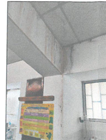
PRESENCIA DE RASTROS DE HUMEDAD Y DAÑO EN PINTURA.
