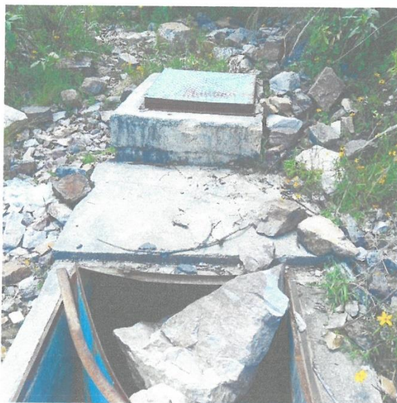
Ilustración N° 07: Vista de la cámara de reunión de captación actual deteriorado de 1.20x0.60m
