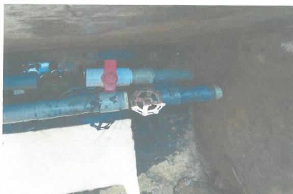
Ilustración N° 08: Vista de la válvula y línea de salida del reservorio a las redes de distribución con reducido diámetro.
