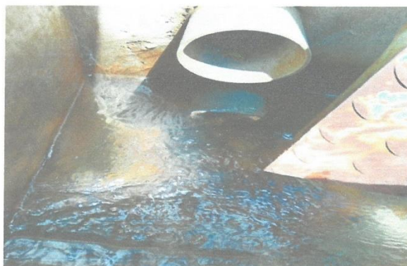
Ilustración N° 06: Vista de la cámara de reunión de 0.60x1.20m deteriorado en el que se observa el agua con alta turbiedad.
