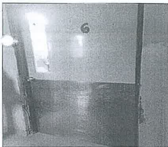
IMAGEN 01: DETRIORIO Y DESGASTE EN EL MARCO Y PUERTA A CAUSA DE LA FALTA DE MANTENIMIENTO.
