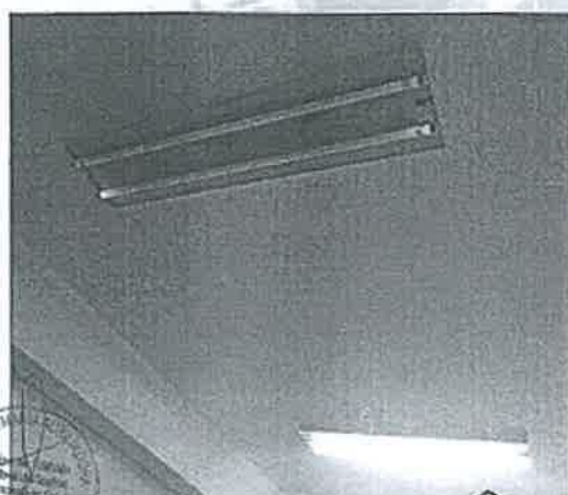
IMAGEN 19: LUMINARIA SIN FUNCIONAMIENTO CON FALTA DE MANTENIMIENTO.
