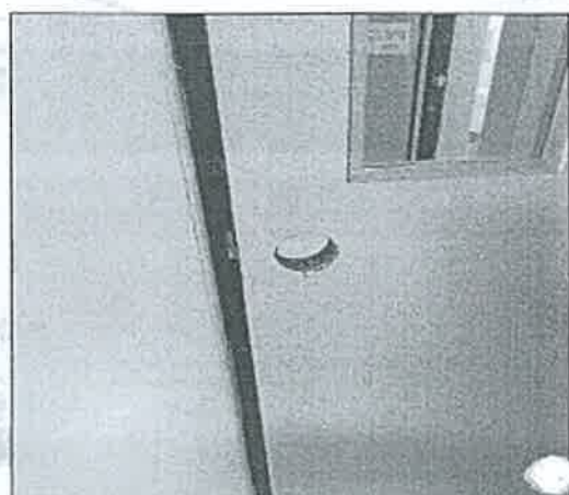
IMAGEN 18: PUERTA SIN CHAPA Y DETERIORADA.
