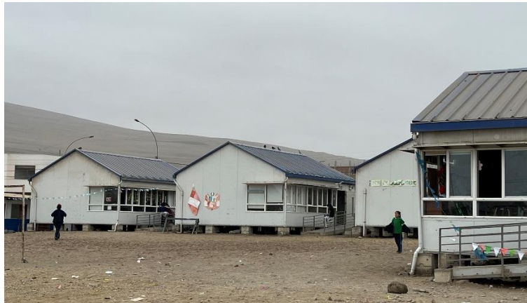
Imagen N°11: Módulos Educativos en Zona Nor Oeste. No cuentan con acometida de energía eléctrica, por lo que pese a tener todas las instalaciones, luminarias, tomacorrientes y demás equipamiento eléctrico, no funcionan por falta de suministro de energía eléctrica.
