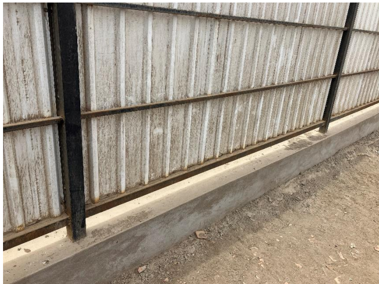
Imagen N°20: Cerco Perimétrico Vista Exterior: Calles 10 de Noviembre, Los Sanitarios y Nasca, que cuenta con cerco perimétrico regular estado que requiere mantenimiento.
