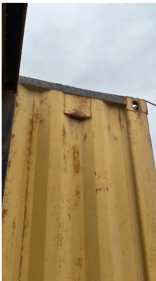
Imagen N°32: Contenedor acondicionado para uso educativo, vista exterior: en mal estado, se aprecia óxido.
