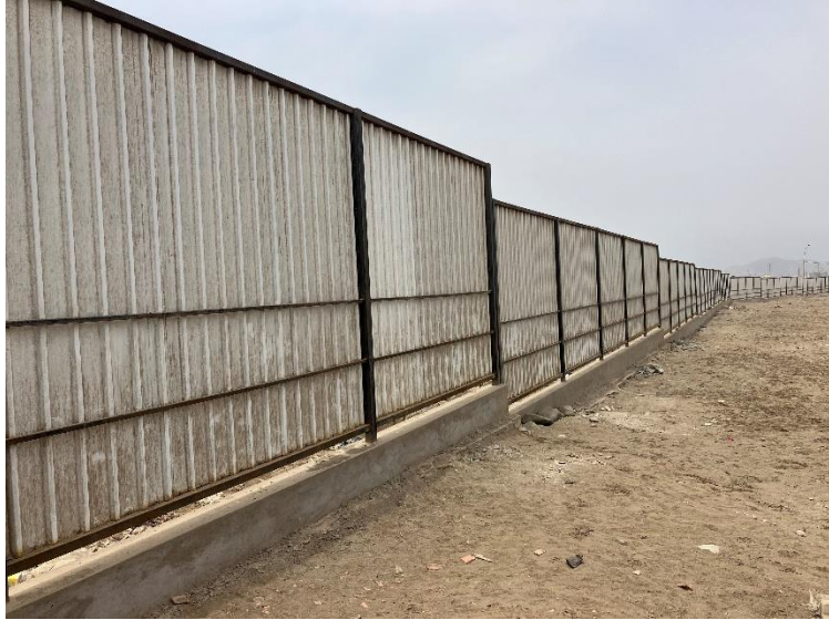
Imagen N°19: Cerco Perimétrico Vista Exterior: Calles 10 de Noviembre, Los Sanitarios y Nasca, que cuenta con cerco perimétrico regular estado que requiere mantenimiento.
